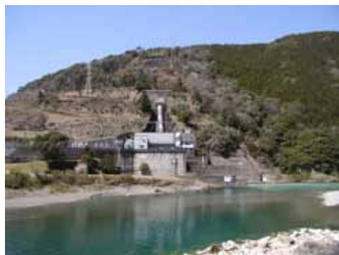
写真 20 十津川第二発電所
