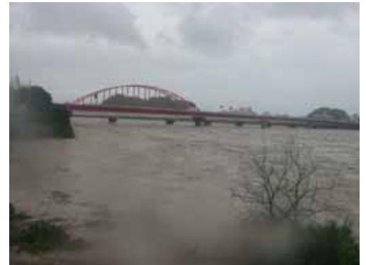
写真7 洪水時の熊野川 (熊野大橋H16.8)
