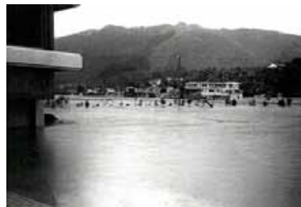
写真 16 本宮地区の浸水状況(S50.8)
