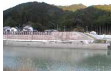
写真11 輪中堤 (相野谷川左岸)
