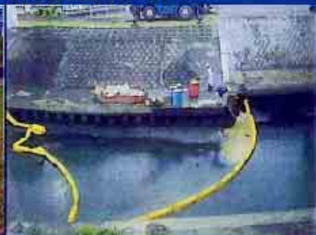
オイルフェンスの設置とひしゃくによる汲み上げ
