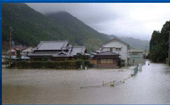
③台風11号出水 (家屋浸水 三重県紀宝町高岡)
