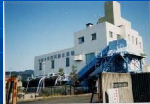
市田川排水機場
