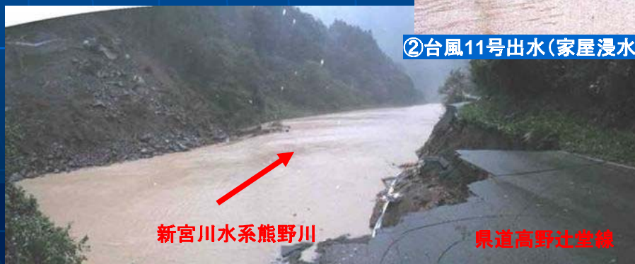
③台風23号出水(県道高野辻堂線崩落 奈良県五條市大塔町)
