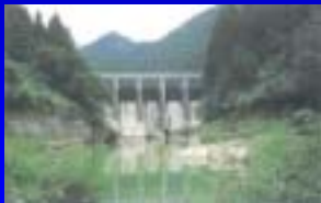
九尾ダム (関西電力)
