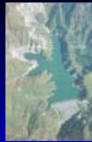
瀬戸ダム (関西電力)
