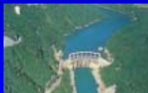
二津野ダム (電源開発)
