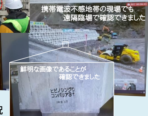
遠隔臨場による確認状況
