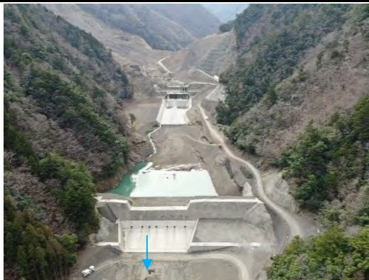
写真No.4 堰堤上流の状況
