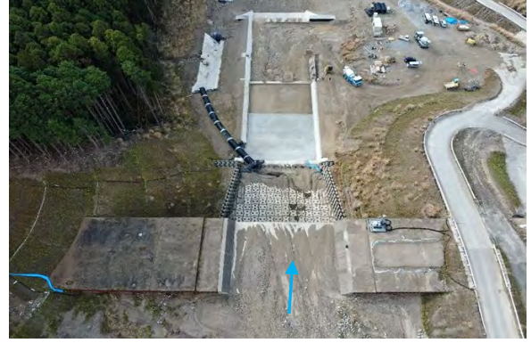
写真No.8 堰堤上流面
