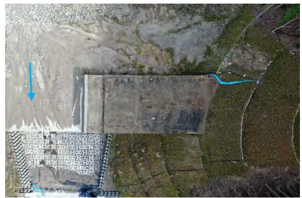
写真No.10 堰堤左岸袖部
