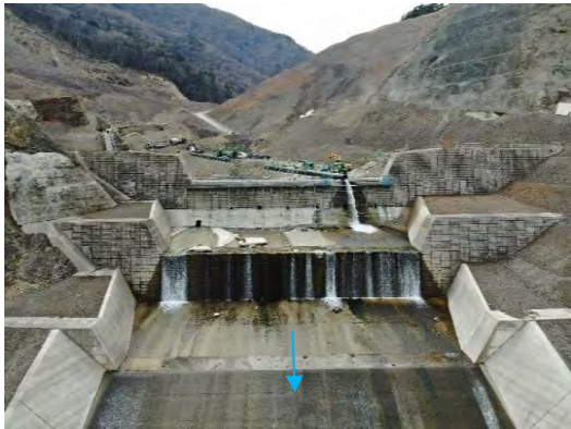
写真No.3 堰堤上流の状況
