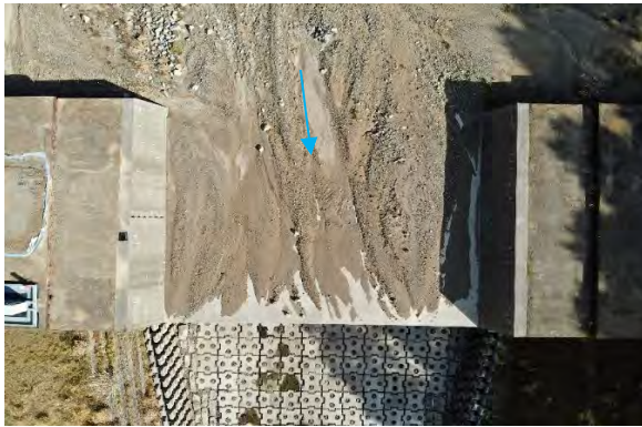
写真No.7 堰堤水通し
