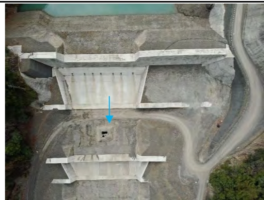
写真No.3 堰堤全景(垂直写真)
