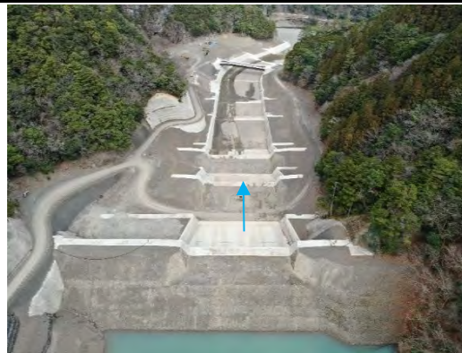
写真No.5 堰堤下流の状況
