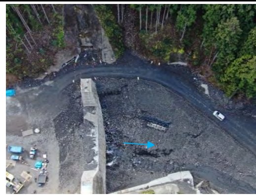
写真No.6 堰堤左岸側壁護岸
