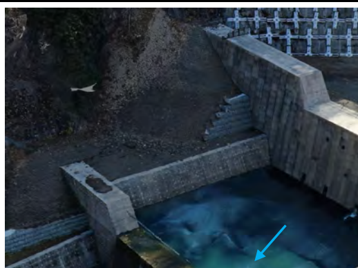
写真No.6 右岸袖、側壁護岸(3次元モデル)
