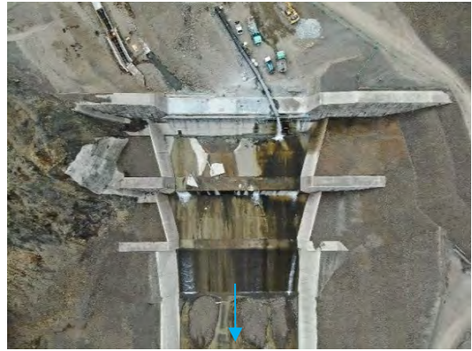
写真No.2 堰堤全景(垂直写真)
