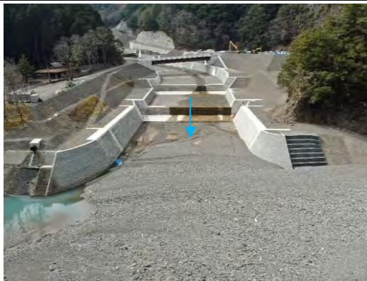
写真No.1 全景
