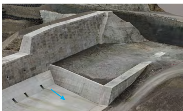
写真No.8 左岸袖、側壁護岸(3次元モデル)
