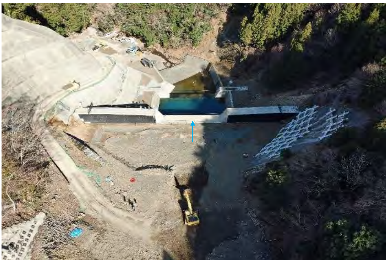
写真No.4 堰堤堆砂状況(拡大)
