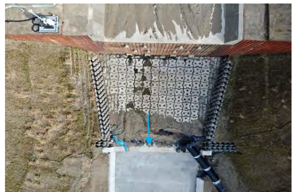
写真No.4 堰堤水叩き
