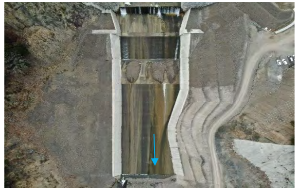
写真No.4 堰堤下流の状況
