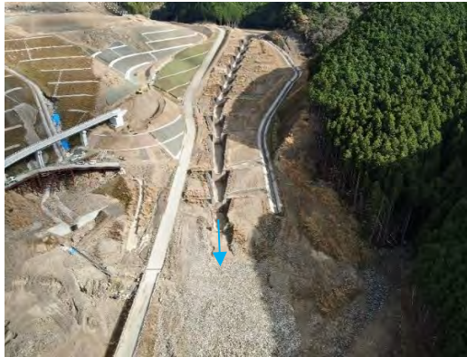
写真No.1 全景
