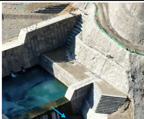
写真No.5 左岸袖、側壁護岸(3次元モデル)
