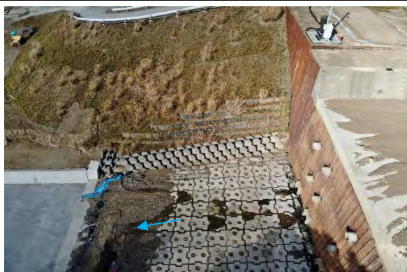
写真No.5 堰堤右岸側壁護岸
