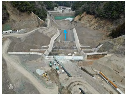
写真No.5 堰堤堆砂状況
