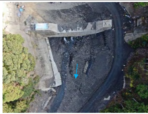
写真No.2 堰堤全景(垂直写真)
