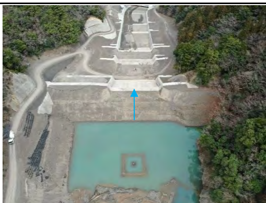
写真No.6 堰堤堆砂状況
