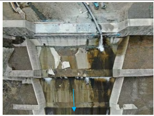
写真No.6 堰堤水叩き、水通し
