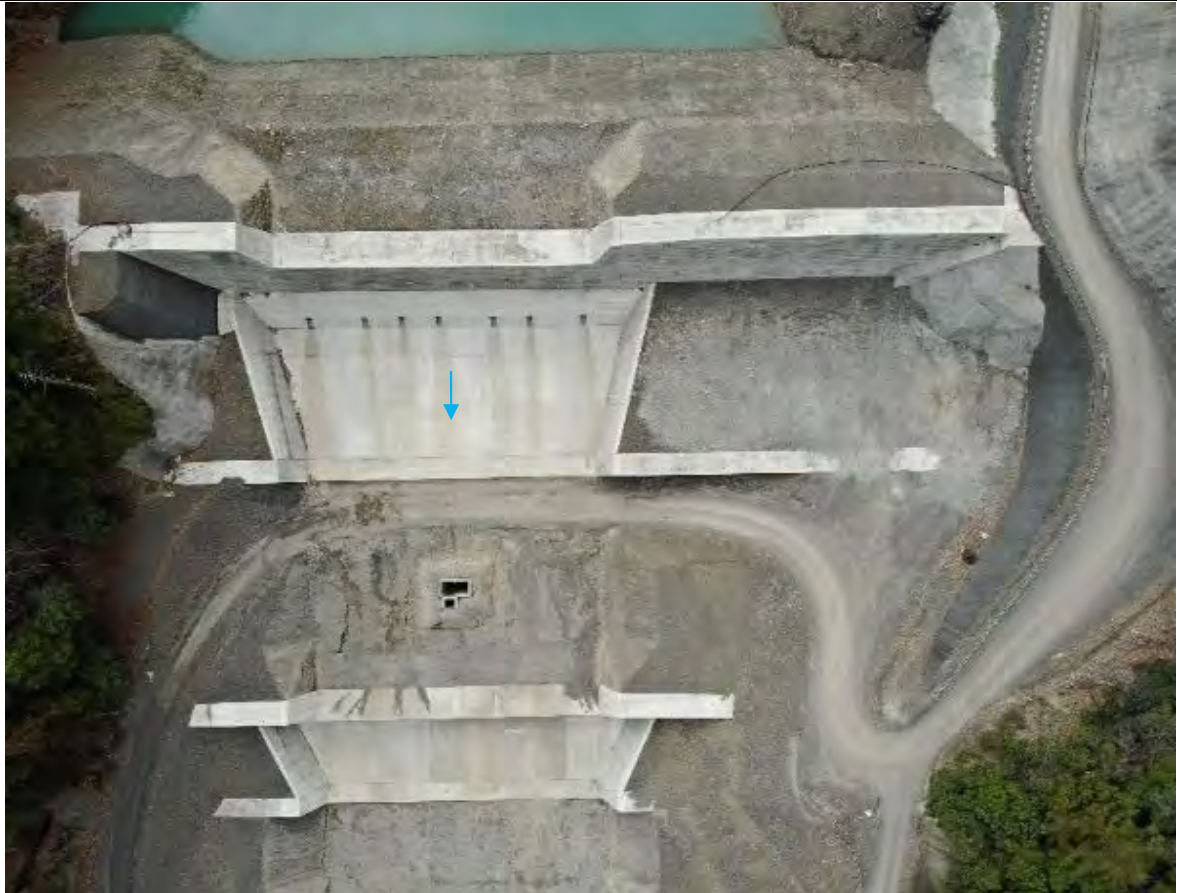
写真No.1 堰堤全景(拡大)
