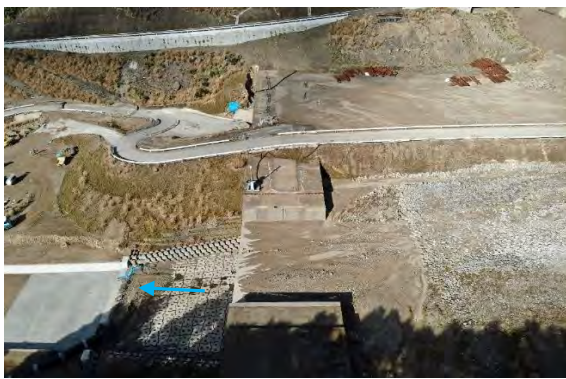
写真No.11 堰堤右岸袖部
