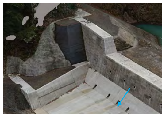
写真No.9 右岸袖、側壁護岸(3次元モデル)
