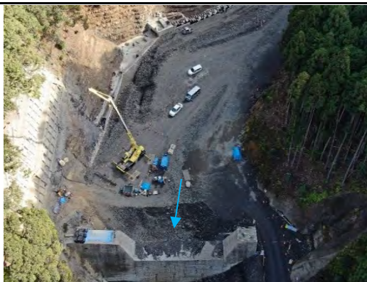
写真No.3 堰堤上流の状況
