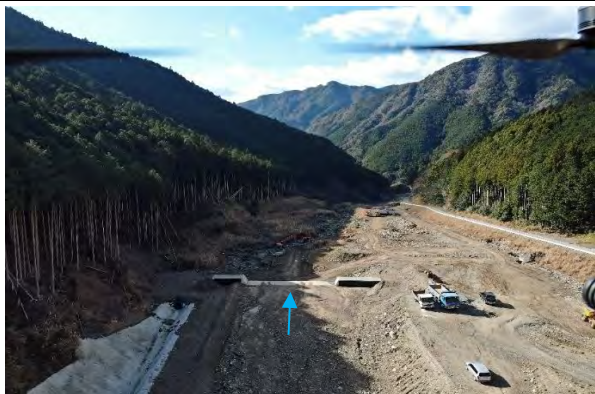
写真No.3 堰堤下流の状況
