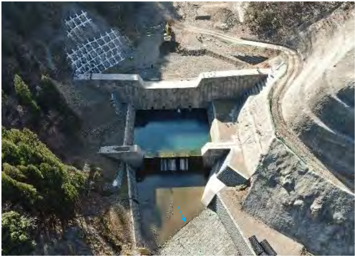
写真No.1 堰堤全景(拡大)
