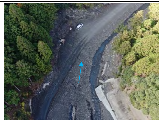
写真No.4 堰堤下流の状況
