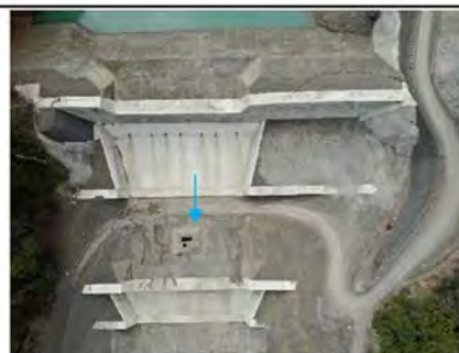
写真No.3 堰堤全景(垂直写真)
