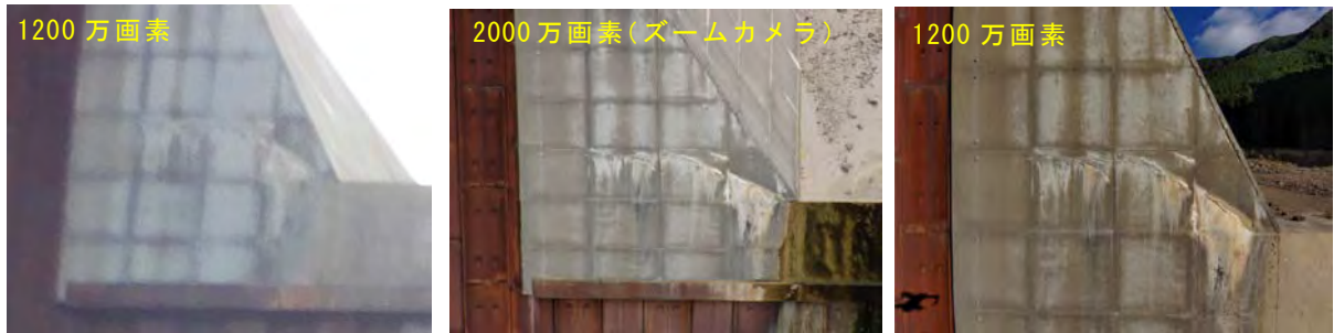
図 5.3.1-1 撮影写真（地上点検、UAV点検（離隔30m）、UAV点検（離隔1.5m））
