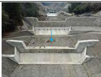
写真No.2 堰堤全景(斜め写真)
