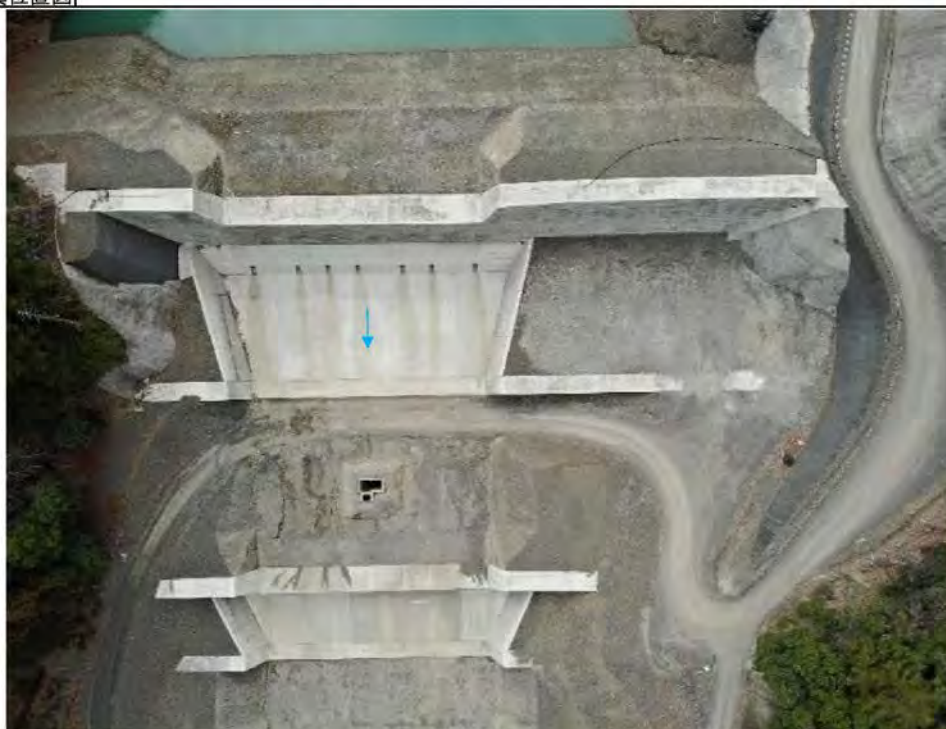
写真No.1 堰堤全景(拡大)
