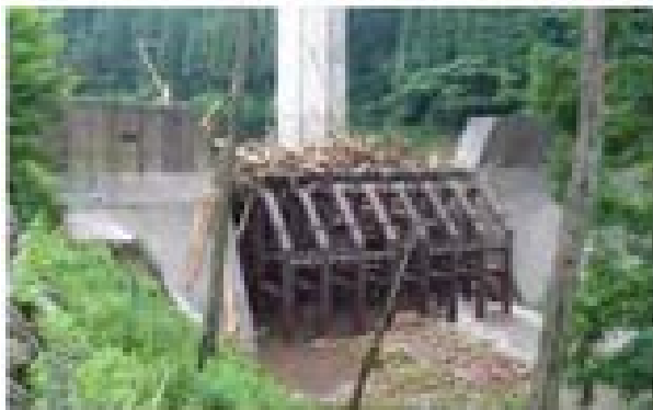
透過型砂防堰堤(熊本県小国町)
