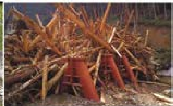
流木捕捉工(大分県中津市)
