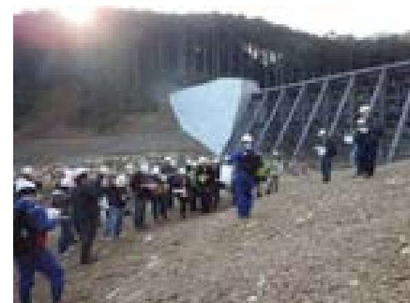
防災ジオツアー 那智川流域における直轄砂防工事現場での土砂災害に関する啓発活動
