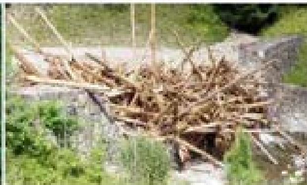
流木捕捉工(兵庫県宍粟市)
