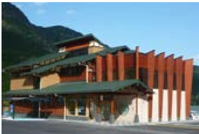
和歌山県土砂災害啓発センター
