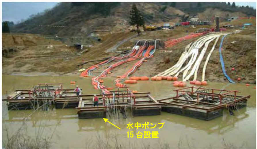
排水ポンプ設置例（東竹沢地区／中越地震）
