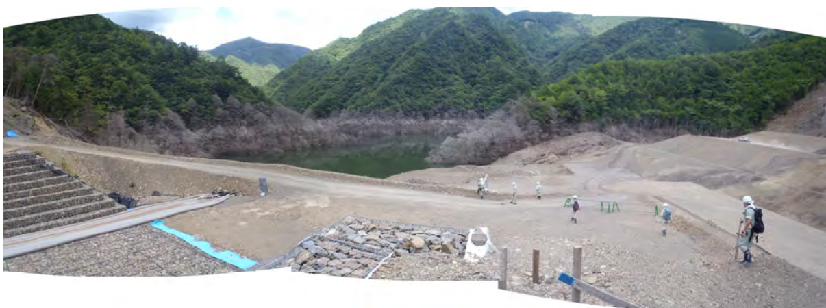
開削による施工状況（栗平地区）
