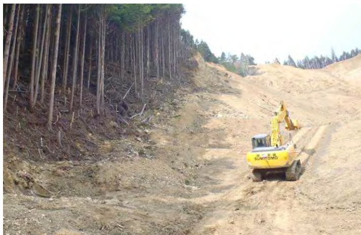
崩壊地内に設置された工事用道路（北股地区）
