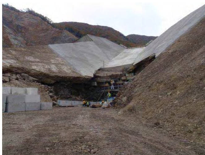
コンクリートによるシュート部被覆（赤谷地区）
