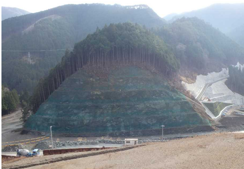
対岸掘削後の状況（坪内地区）
