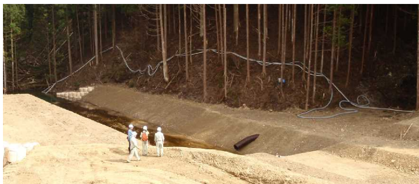
排水ホース設置状況（北股地区）
