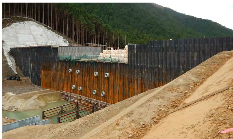
基幹となる砂防堰堤（熊野地区）
