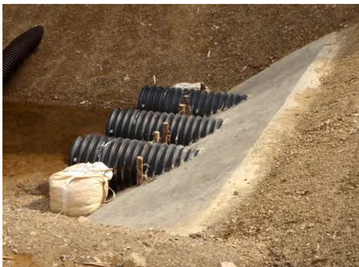
暗渠排水管呑口部の補強（北股地区）
