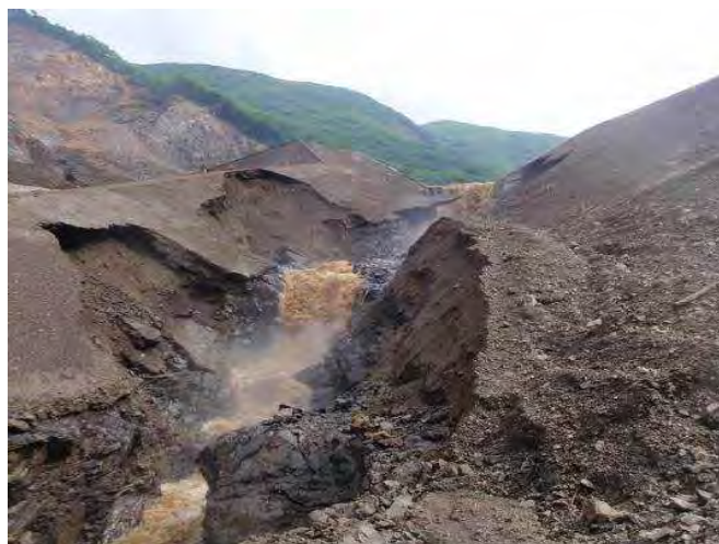
越流によるシュート部の破損（赤谷地区）
