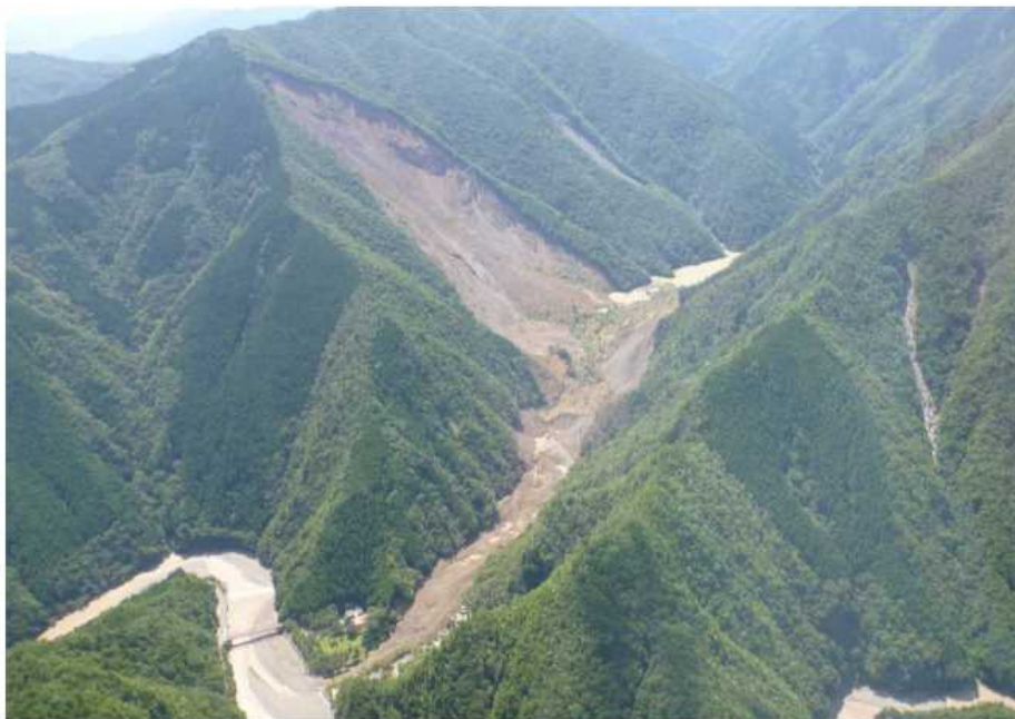
ヘリコプターからの河道閉塞箇所の撮影（赤谷地区）
