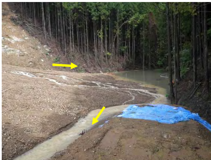
開水路区間への土砂流入（北股地区）
