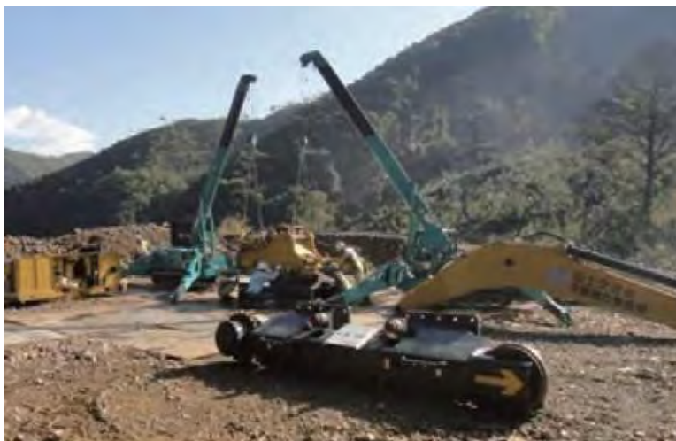
カニクレーンによる分解型重機の組み立て（長殿地区）
