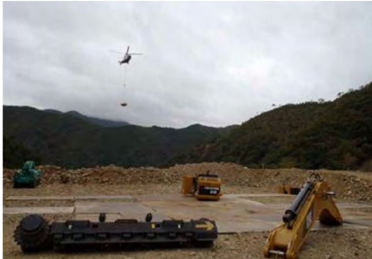
ヘリコプターによる分解型重機の輸送（長殿地区）
