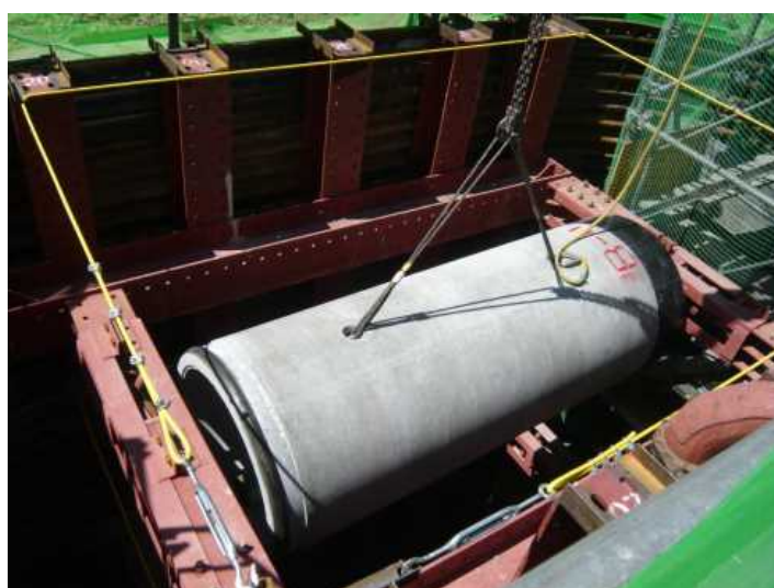
推進工法により設置した暗渠管（栗平地区φ800mm）
