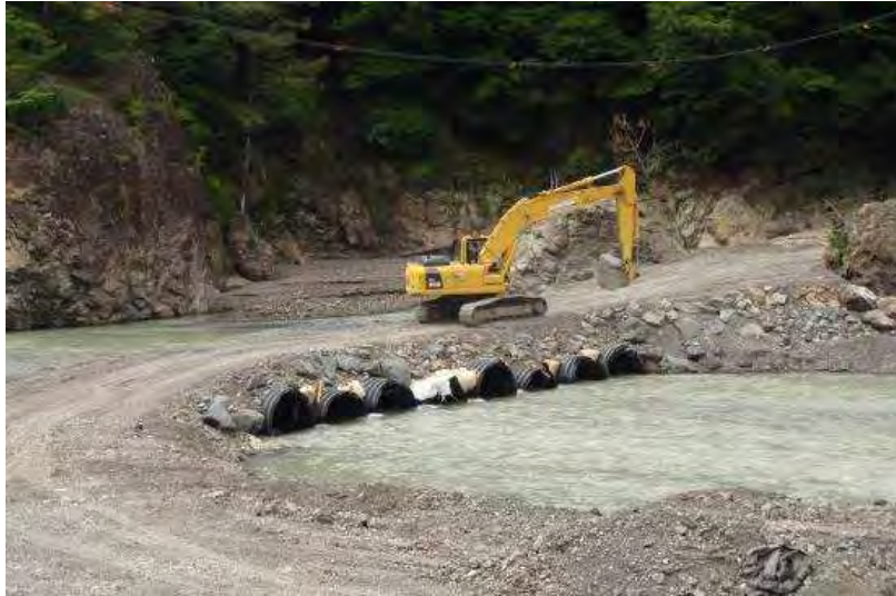
コルゲート管による渡河道路（長殿地区）
