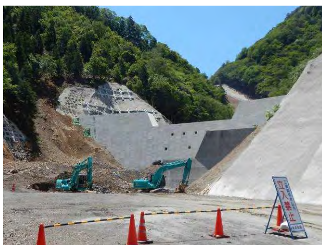
天然ダム脚部への基幹堰堤設置（長殿地区）
