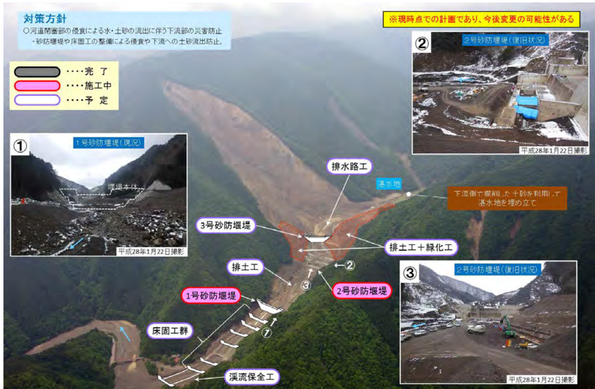
堰堤工群による河道閉塞対策（赤谷地区）
