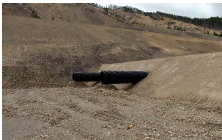
暗渠排水管呑口部の状況（栗平地区）
