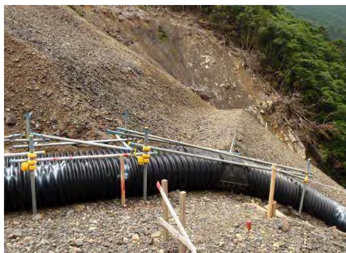
排水ホースの固定状況（栗平地区）
