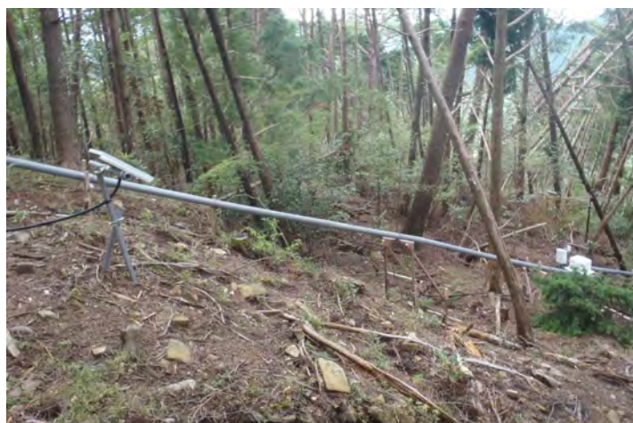
伸縮計による計測（熊野地区）
