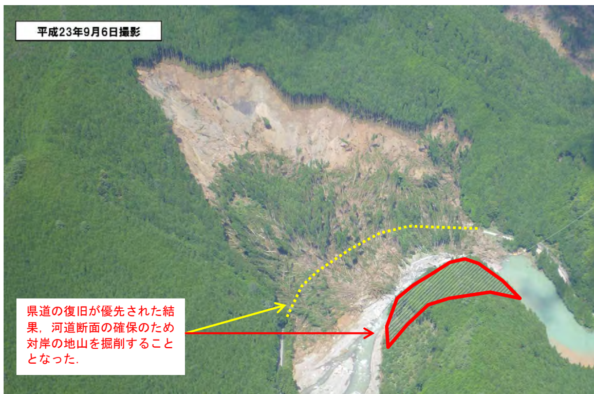
道路復旧と対岸掘削箇所の状況（坪内地区）
