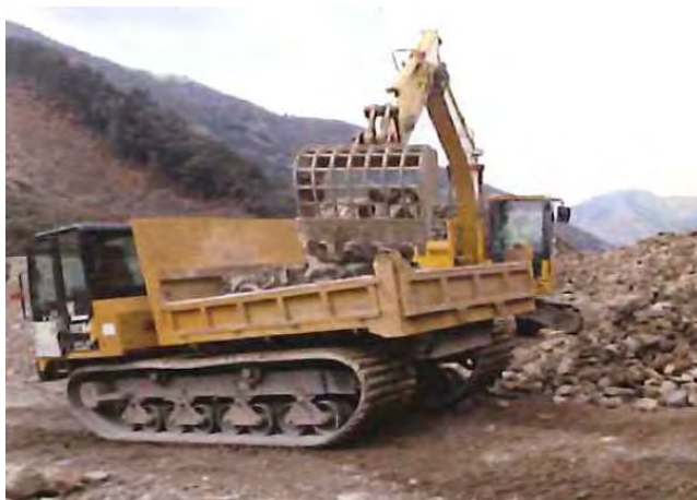
不整地運搬車（栗平地区）
