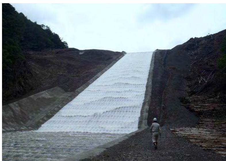
イボ型水路の流下状況（栗平地区）
