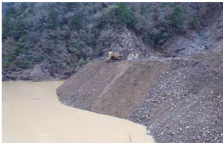
湛水池への埋め戻し（赤谷地区）
