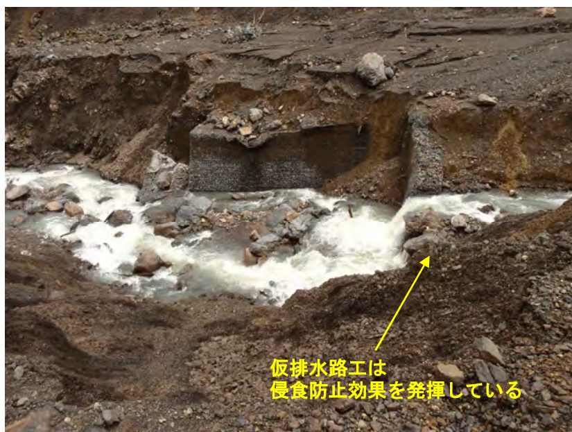
平成26年台風11号時の仮排水路工の状況（赤谷地区）
