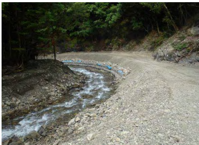
河床道路の設置状況（栗平地区）
