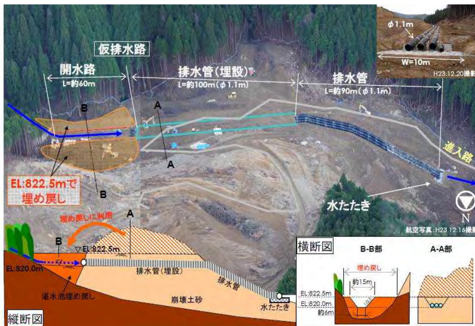
河道閉塞部の切り下げと湛水池の埋め戻し（北股地区）
