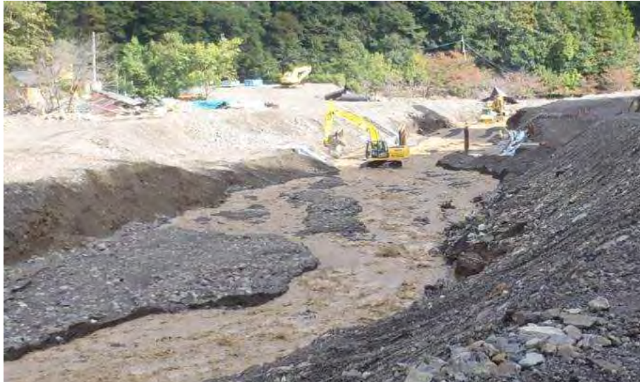
赤谷川流路の河道掘削（赤谷地区）
