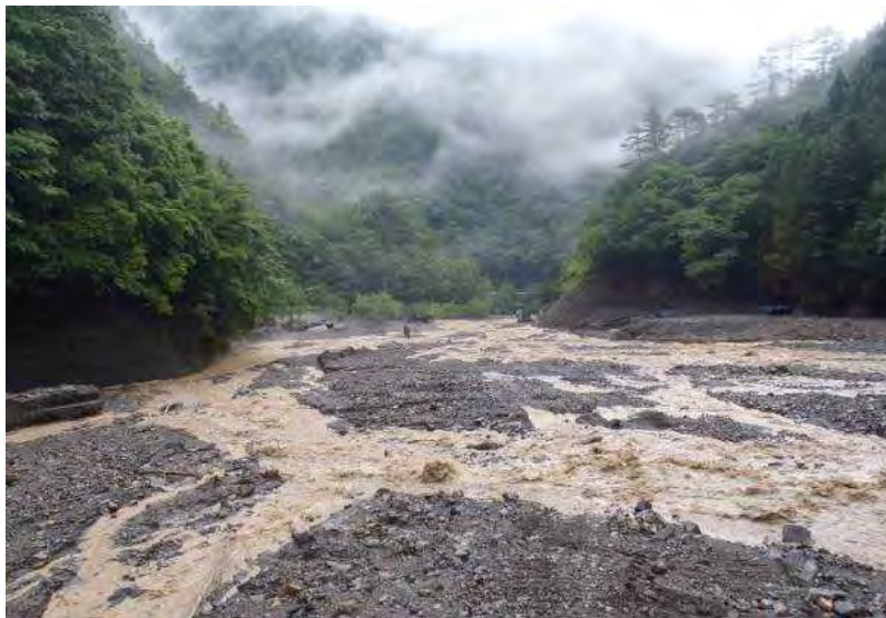
赤谷川沿いの工事用道路の河床変動（赤谷地区） 上：平常時、下：出水時
