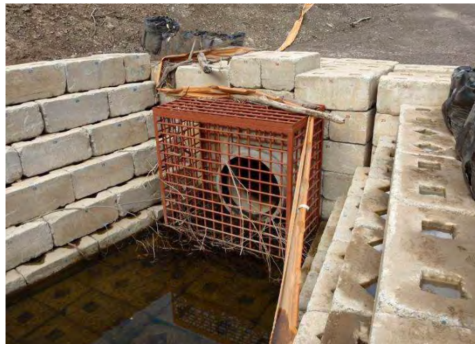
ブロックによる補強後の暗渠排水管の呑口部（赤谷地区）
