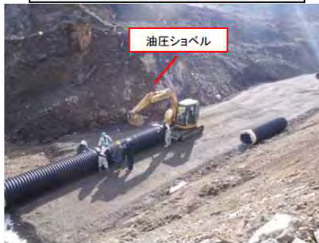
暗渠排水管の設置（赤谷地区）
