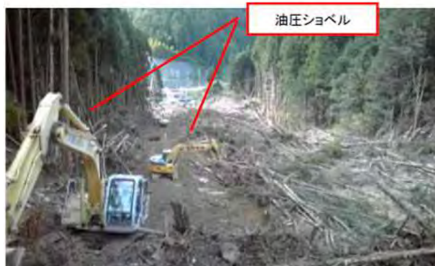
進入路整備状況（北股地区）
