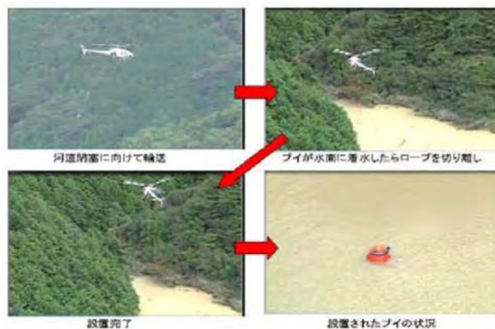
土研式水位観測ブイ（投下型）の設置状況（熊野地区）
