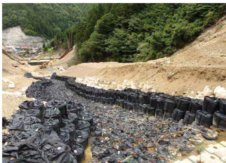
砂防ソイルセメントを中詰材とした大型土のう水路（北股地区）
