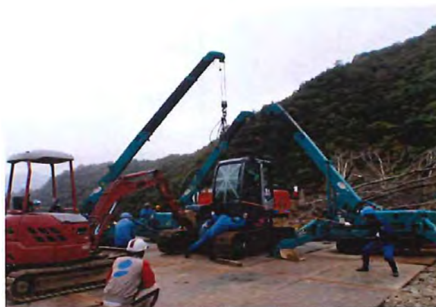
分解型重機（バックホウ）の組立状況（栗平地区）
