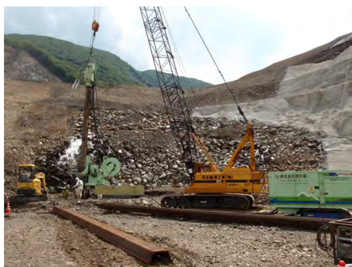
湧水箇所の対策状況（赤谷地区）
