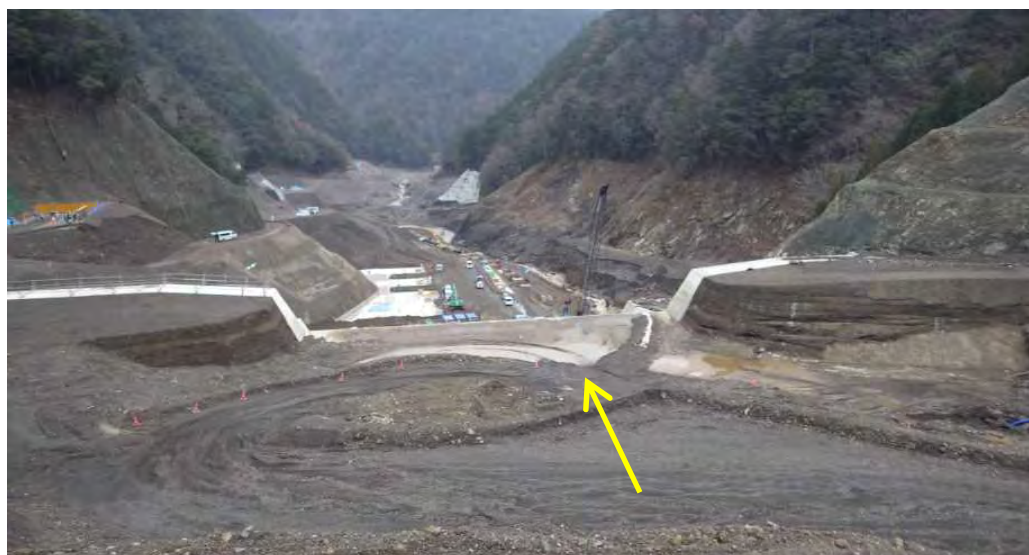
砂防ソイルセメントによる袖部上流側の被覆（赤谷地区）
