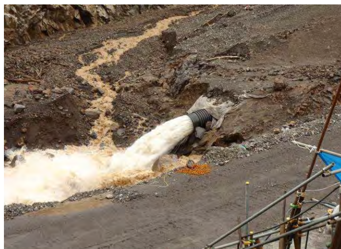
暗渠排水管吐口部の状況（赤谷地区）
