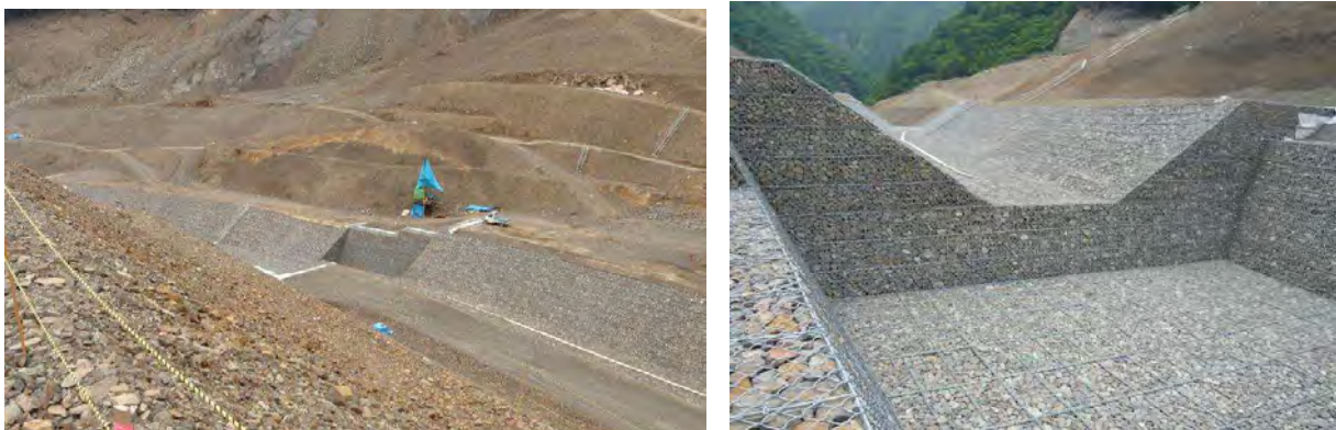
仮排水路施工状況（赤谷地区）
