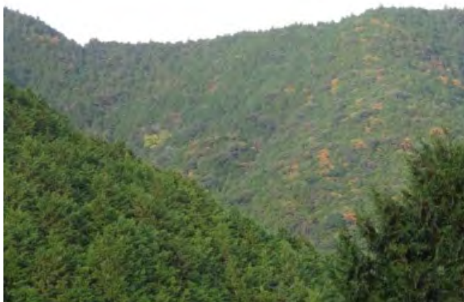
写真 10.6 松葉集落上流の崩壊地
