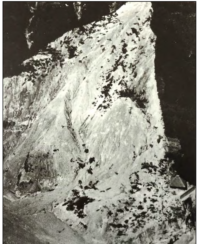
写真 11.3 北寺の大規模崩壊（右下に観音堂） （かつらぎ町所蔵：芝純一氏撮影）
