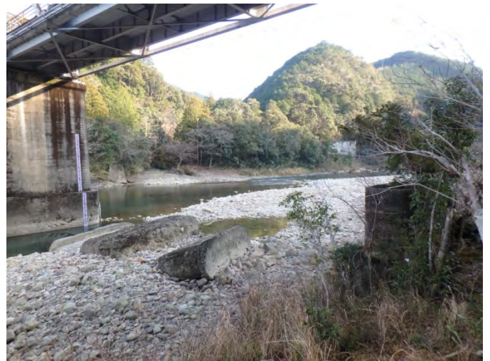
写真 9.4 現市鹿野橋と旧市鹿野橋の橋台
