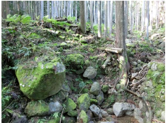
写真 7.10 厚く堆積した土石流堆積物 平成23年(2011)の土石流発生時には人家はなかった
