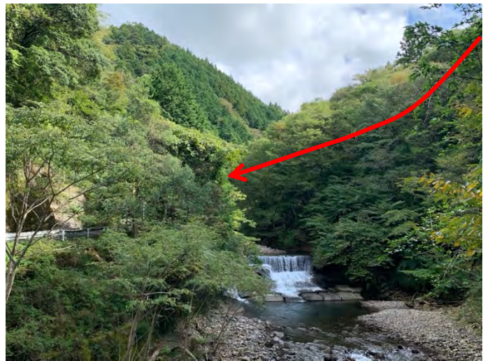
写真12.5 朔日川の天然ダム形成地点 (2020年撮影)
