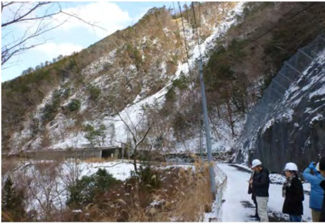
十津川・林新湖を形成した高津中山の崩壊地
