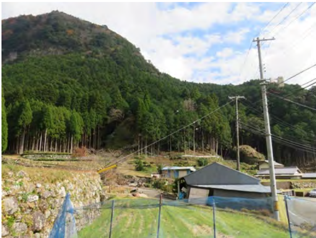
写真8.9 ⑦口色川・県(あがた)川左岸の露岩地急崖の下部の水田は植林のため、大転石はよく見えない
