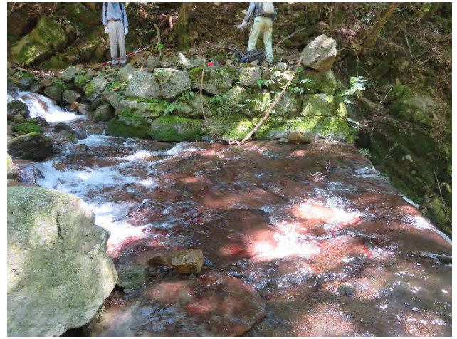
写真 13.10 №1 砂防堰堤左岸 天端幅が 4.3m と最も厚く、基幹堰堤としての 位置づけが想定されます。(2020 年撮影)
