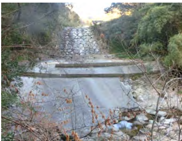
写真 10.12 対岸から見た迫戸の巨石積堰堤 (2019年, 上森撮影)
