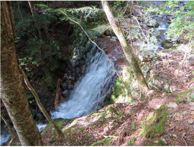
写真 13.9 №1 砂防堰堤全景 緩いアーチ構造をしています。 (2020 年撮影)
