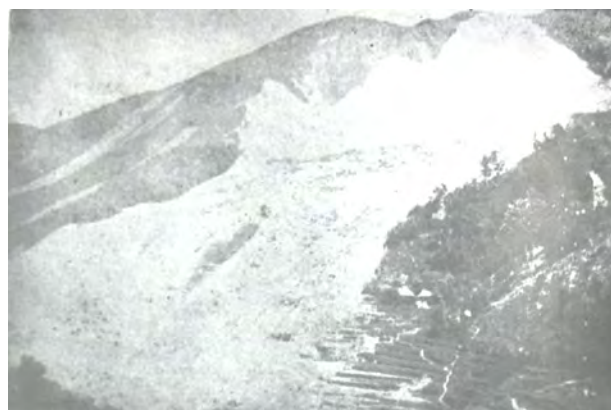
写真 10.1 槇山の大規模崩壊直後の写真 (明治大水害誌編集委員会, 1989)
