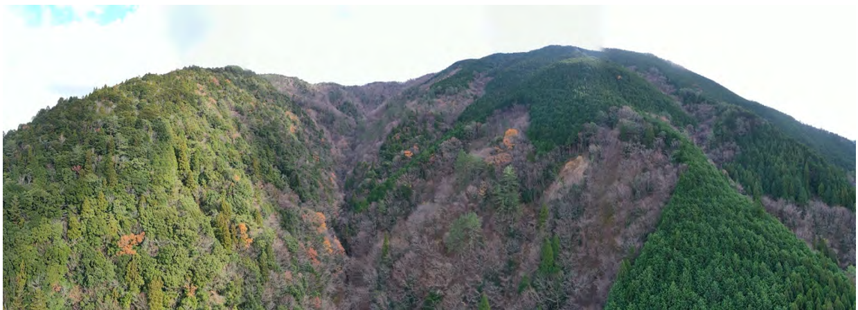
写真 12.22 亀田山の崩壊斜面 (2020年 UAV による撮影)
