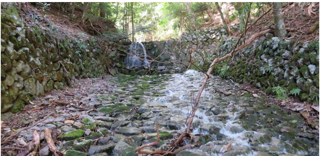
写真 13.12 №9 砂防堰堤全景 現存が確認された最上流部の砂防堰堤です。割石の谷積で、積石は 整形されていません。(2020 年撮影)
