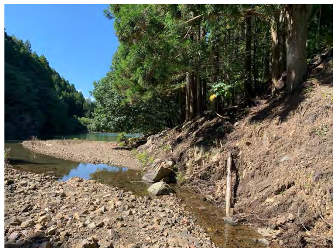
写真 12.3 山津波による土砂の堆積 (2020年撮影)
