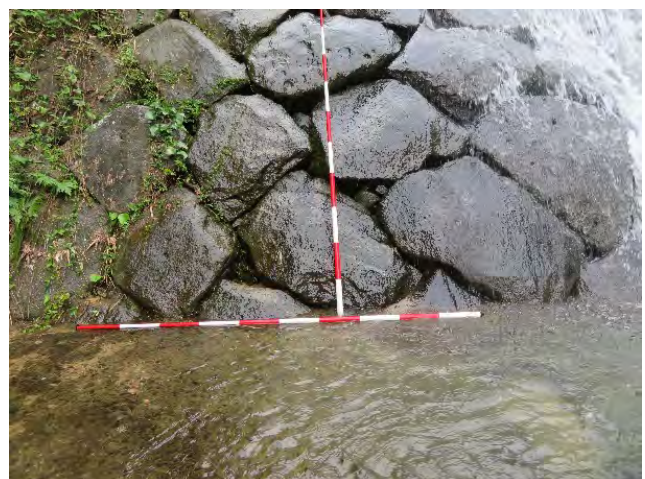
写真 10.14 迫戸の堰堤上段の積石 (2020年撮影)
