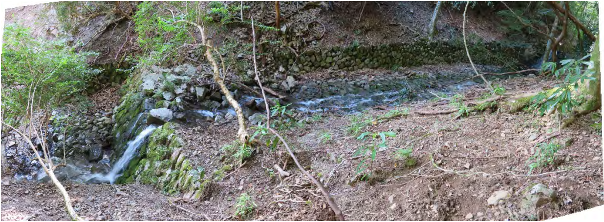
写真 13.11 №8 砂防堰堤及び上流の流路工 №8 砂防堰堤と№9 砂防堰堤の間には石積流路工が現存しています。 流路工は長さ 27m、幅 6.2m。(2020 年撮影)
