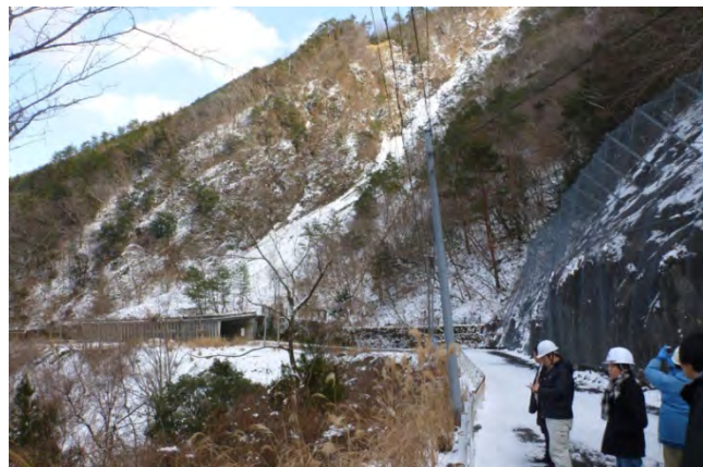
写真6.1 林新湖を形成した高津中山の崩壊地と旧国道の洞門(崩壊は続いている)
