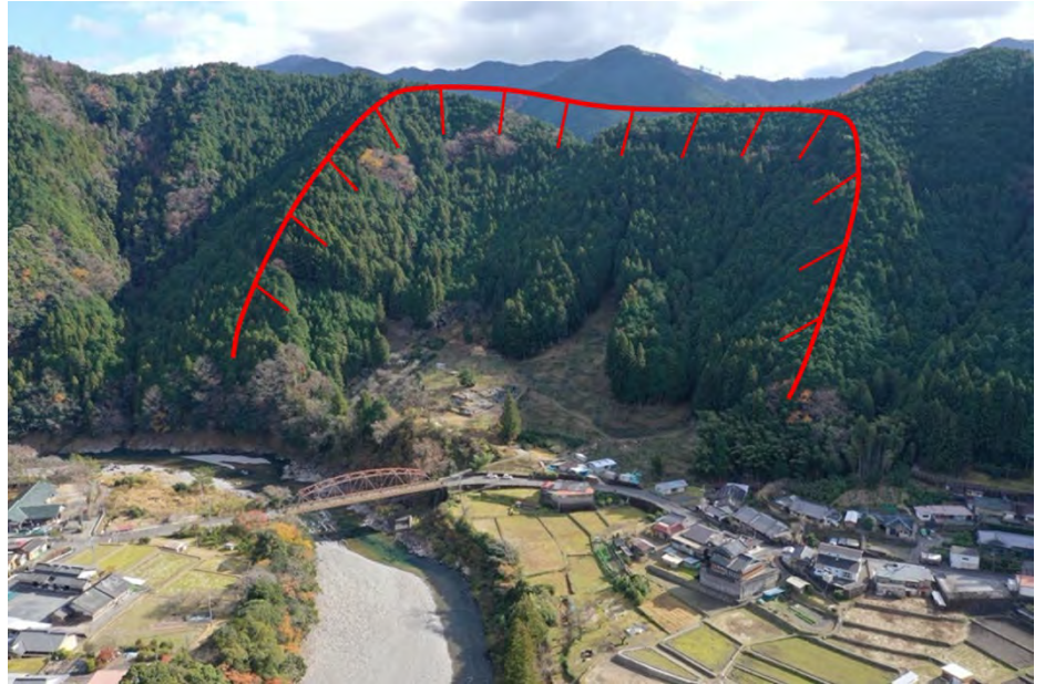
写真 12.17 下柳瀬の崩壊跡地 (2020年 UAVによる撮影)
