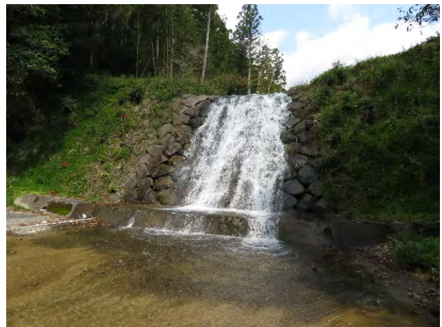
写真 10.13 迫戸の堰堤上段根固工 (2020年撮影)
