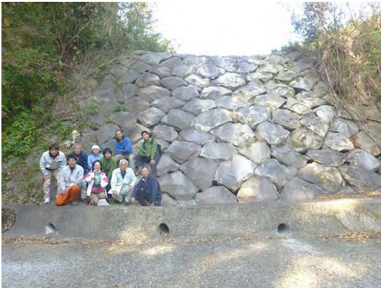
写真 10.15 迫戸の巨石積堰堤 (2018年撮影)
