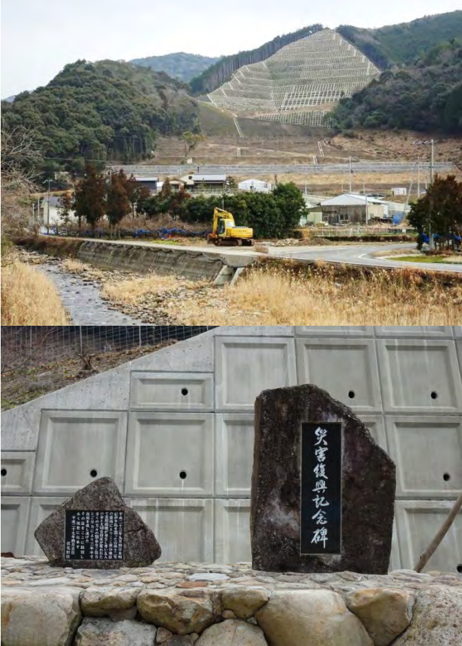
写真10.5 伏菟野の深層崩壊(上)と災害復興記念碑(下)
