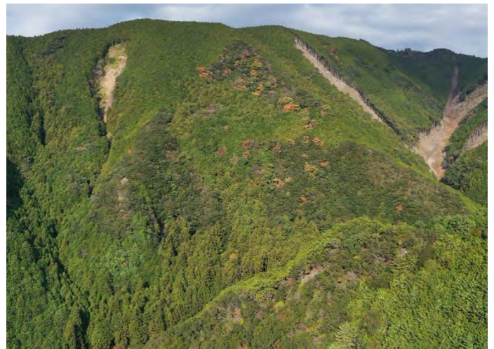
写真13.6 現在の篠原谷の崩壊地 (2020年 UAVによる撮影)
