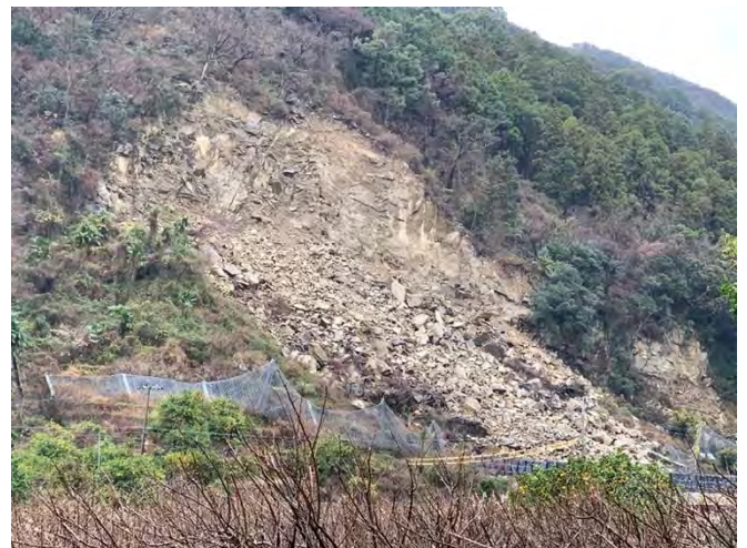
写真 10.11 令和元年(2019)7月28日の崩壊地 (2020年撮影)
