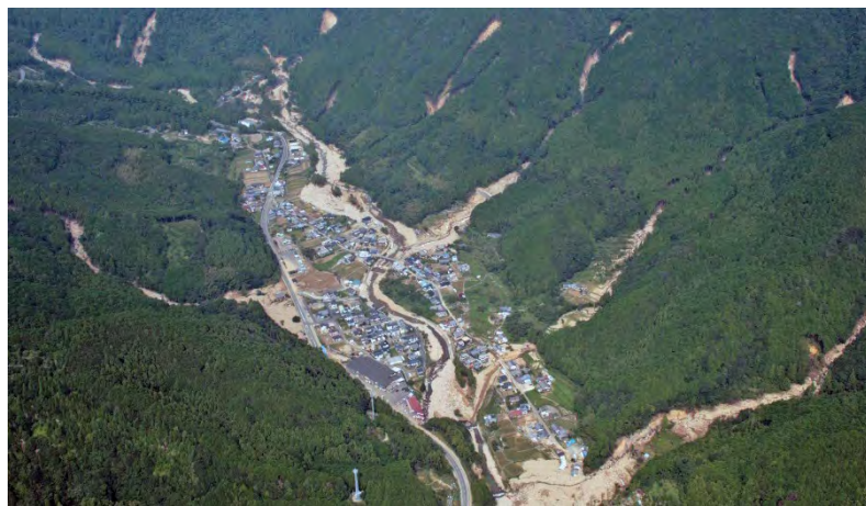
平成23年台風12号により土石流が発生した那智川流域
