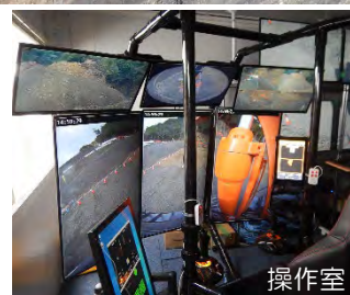
栗平地区における無人化施工
