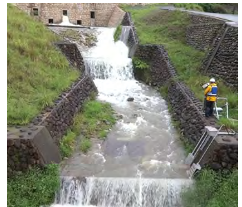
出水時の河川流速観測
