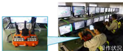
赤谷地区における無人化施工
