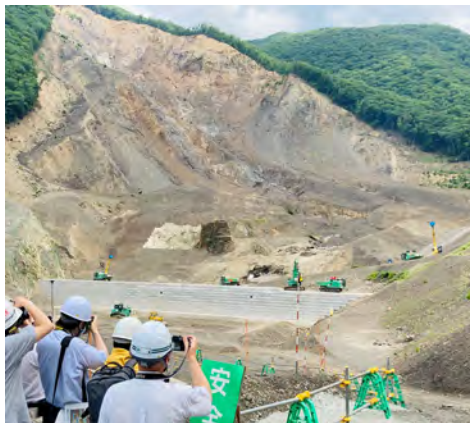
大規模崩壊地における自動化施工
