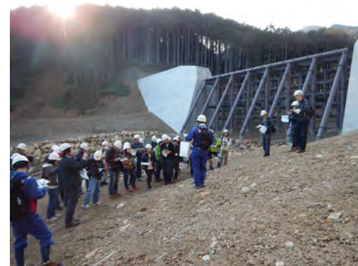
砂防対策工事の説明
