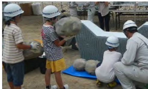
堰堤の修景工事体験
