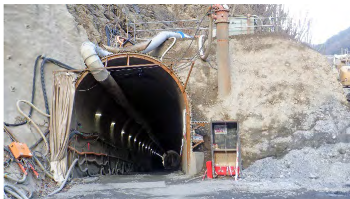
長殿排水トンネル工事の様子
