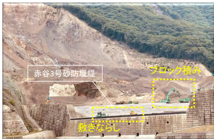
自動化施工による砂防堰堤の施工の様子(赤谷地区)
