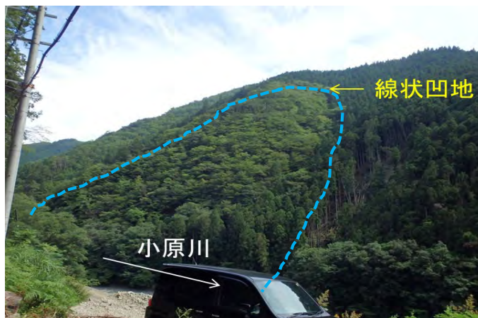
現地調査による危険斜面の抽出
