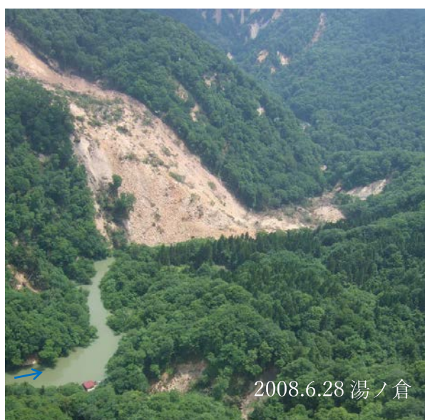
図-1 2008年岩手・宮城内陸地震で発生した湯ノ倉の河道閉塞(天然ダム)
