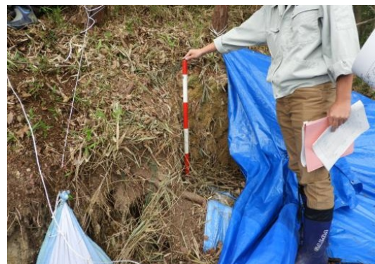
写真-2 斜面頂部での変状(有功地区)
