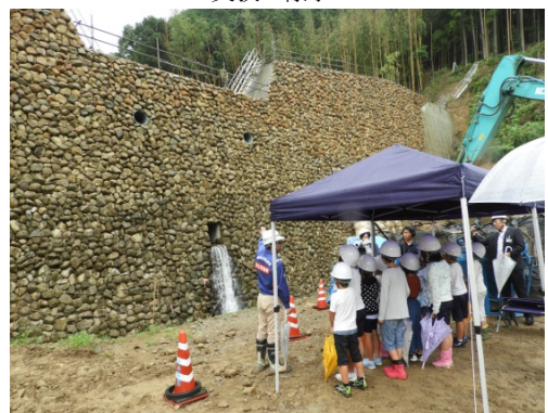
写真-4 砂防えん堤工事現場の現地見学の様子
