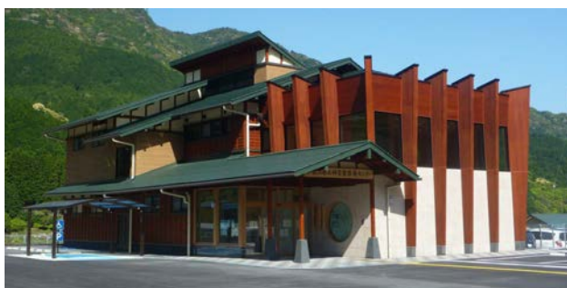
図-6 大規模土砂災害対策技術センター（写真は和歌山県土砂災害啓発センター。同センター内に設置）
