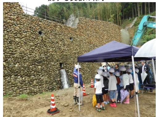
写真-5 砂防えん堤工事現場の現地見学の様子
