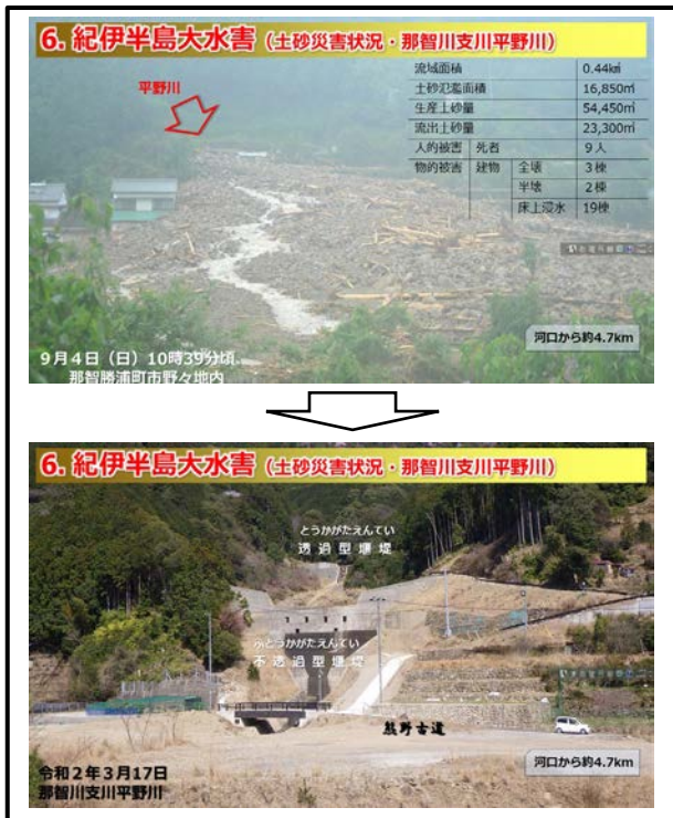
図-3 被災時と復旧状況の対比を示す研修資料
