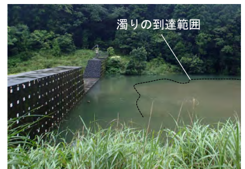
写真-1 堰堤での濁り滞留状況
