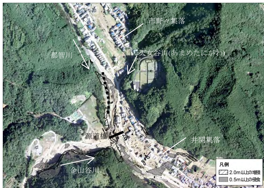
図-3 災害前後の空中写真測量を基にした地形データの差分図(那智川本川と金山谷の合流点を含む広域図)。矢印は流向を表す。図中点線は背割堤の位置を表す。
