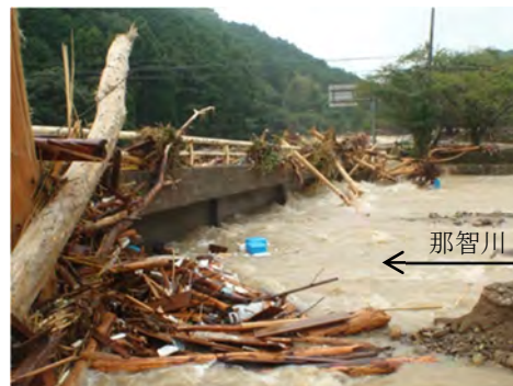
写真-3 源道橋上流での流木の堆積。矢印は流向を示す。
