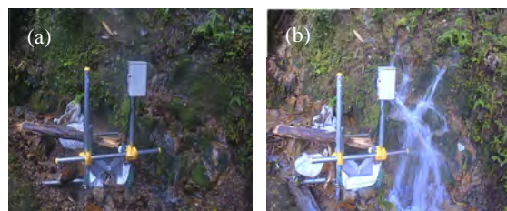
写真-2 地層境界付近からの湧水 (a)常時 (b)豪雨時 (2017/10/23)
