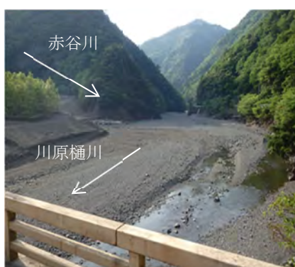
写真-2 赤谷川と川原樋川の合流点付近の河床上昇の様子(平成29年5月)。矢印は流向を示す。
