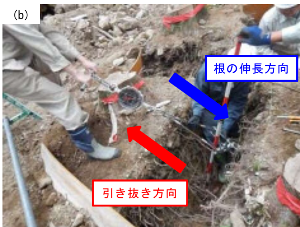
写真-3 引き抜き試験の様子。(a) 引き抜き専用工具、(b) 引き抜き作業の様子。
