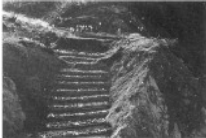
図-5 応急水路開削状況(昭和28年8月17日)
