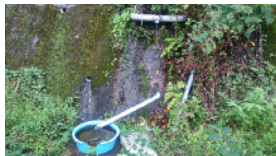
写真-2 重力式擁壁からの排水
