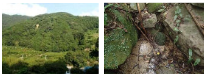
図-2 左図：岩盤クリープ (図-1 中①から撮影) 右図：岩盤クリープ斜面基部から湧出する湧水
