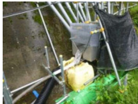
写真-1 横ボーリング工からの排水
