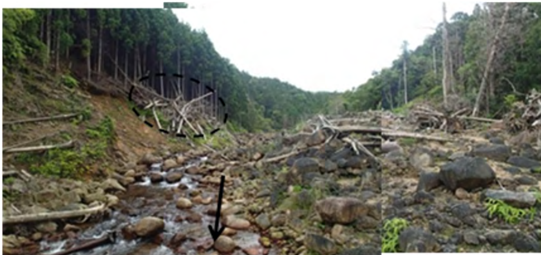
写真-1 平成23年台風12号による荒木川流域内での河道閉塞の状況 （点線は左支川からの土石流で対岸へ乗上げた流木を示す）
