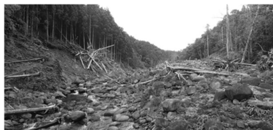
写真-5 支川からの土砂流入により本川が河床上昇している様子（矢印は流下方向）
