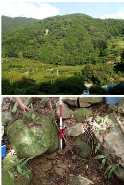
図-4 (上) 図-3 中①から見る岩盤クリープ斜面 (下) 岩盤クリープ斜面 A の下部から湧出する湧水
