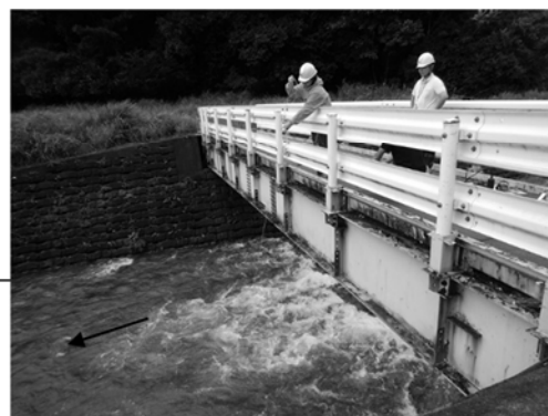
写真-3 下流側の観測箇所
