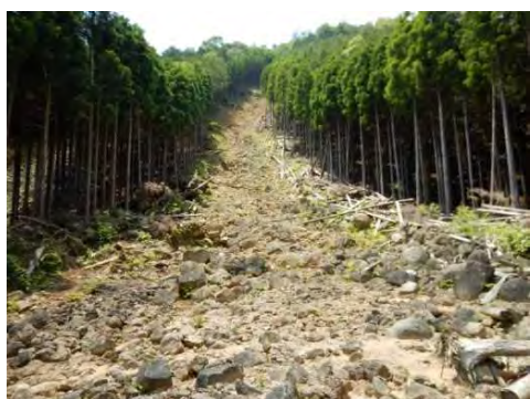
写真-3 平成23年台風12号による荒木川流域内での山腹崩壊の状況
