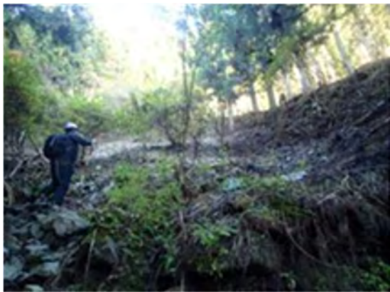
図-8 支溪流3に存在する崩壊跡地形
