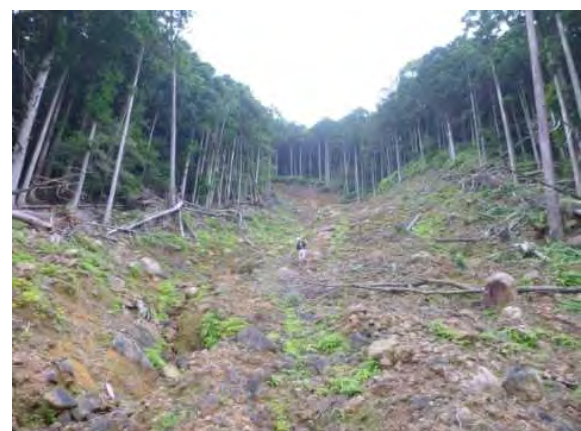
写真-2 山腹崩壊(左支川1)の事例
