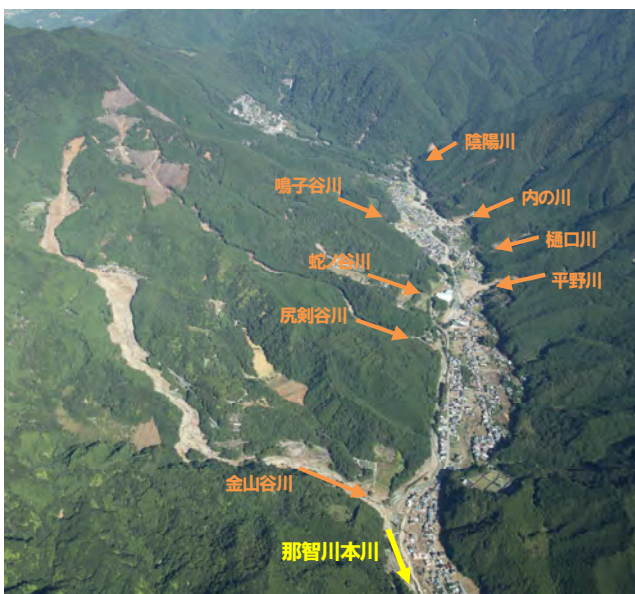
図-1 那智川流域の土石流発生状況 (H23年台風12号)
