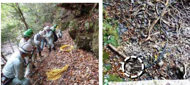
写真-1 (左) 通信ケーブル敷設状況 (右) 通信ケーブル破断状況 (栗平地区)
