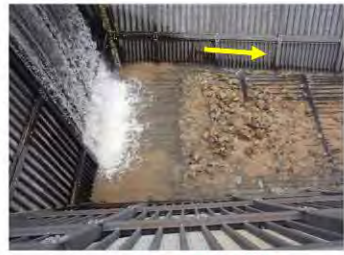
【H25台風18号】・排水路の破損
