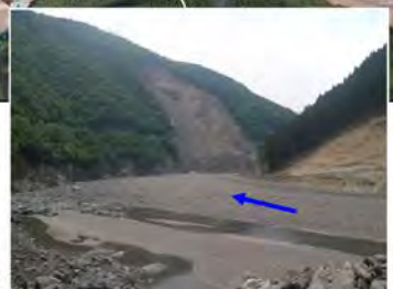
土砂堆積状況
