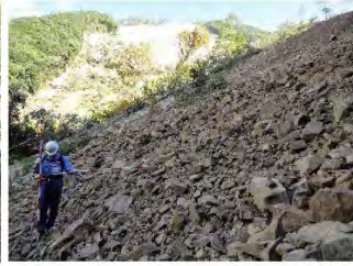
⑥ 傾斜約30度で概ね安定している
