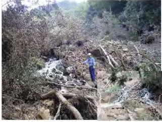
④ 漏水状況
