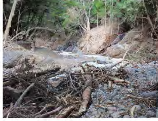
② 長殿谷の状況
