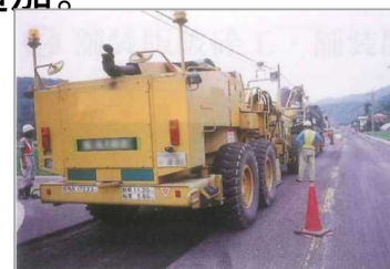
路面切削作業
