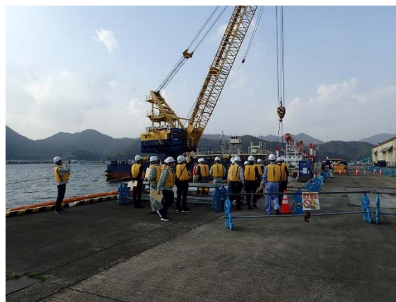
【施工状況の見学①】
