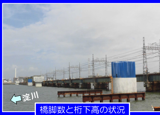
改築工事が進む阪神なんば線淀川橋梁
