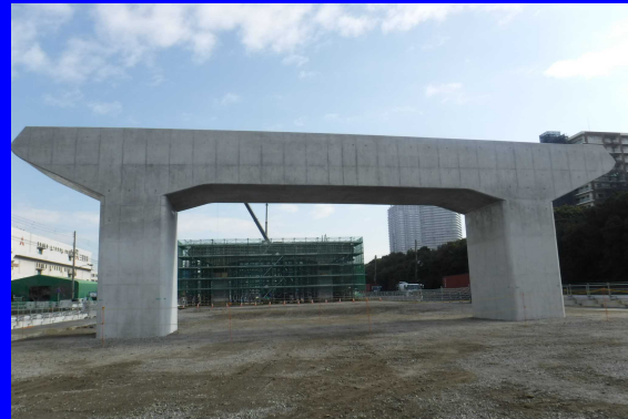
高架橋下部工事の様子
