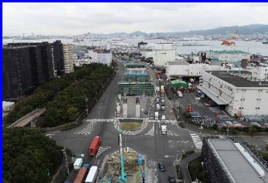
六甲アイランドの工事の様子
