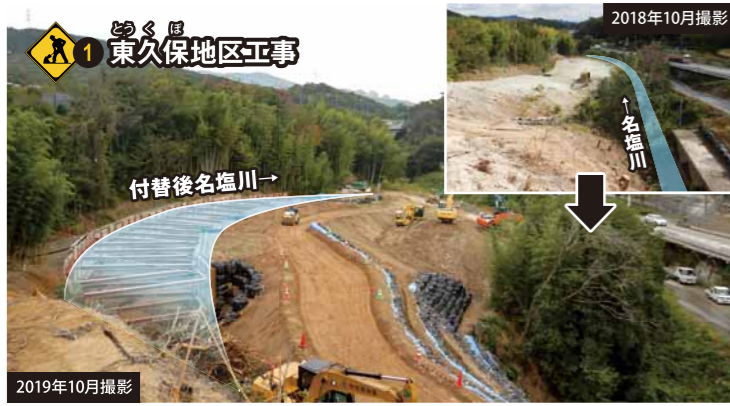
名塩川を付け替えながら、改良工事を行っています。
