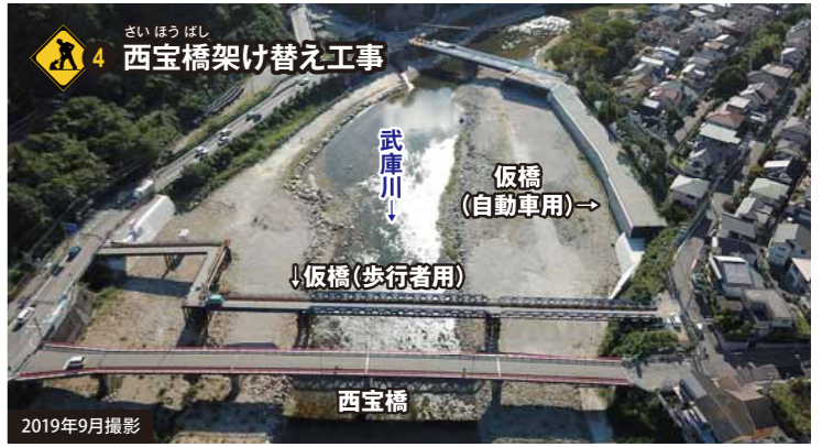
西宝橋の架け替え工事を進めています。
