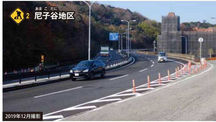
通行車線の4車線化が完了しました。(詳しくは裏面へ)
