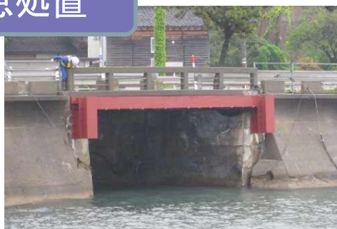
応急処置後の状況
