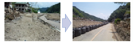
災害時の道路啓開
