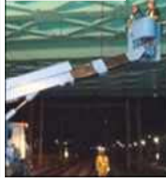
跨線橋の点検
