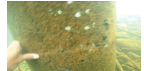
鋼管の腐食状況
