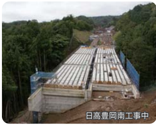
日高豊岡南工事中
