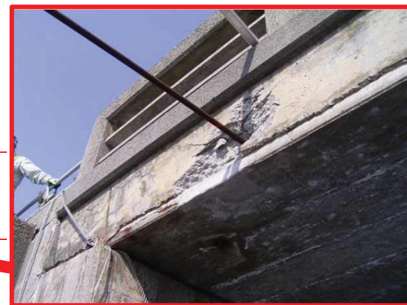
(海側) PC鋼棒 φ23, L=3m突出
