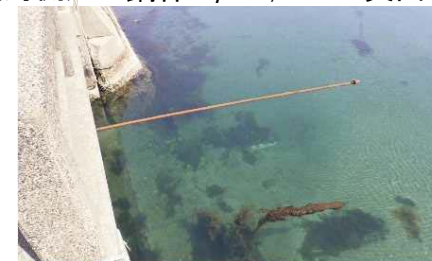
(海側) PC鋼棒 φ23, L=3m突出
