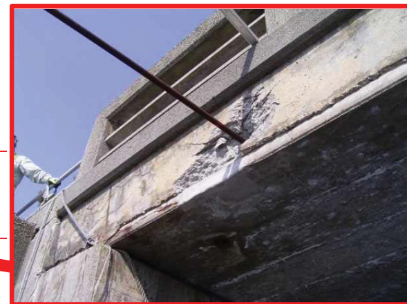
(海側) PC鋼棒 φ23, L=3m突出
