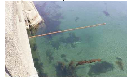
(海側) PC鋼棒 φ23, L=3m突出
