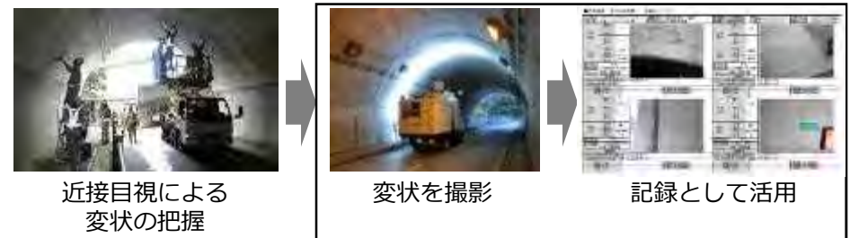
＜トンネルの点検記録作成支援技術の試行イメージ＞
