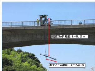
「橋梁点検カメラシステム視る・診る」 による近接目視、打音調査等援助・補完技術 ジビル調査設計
