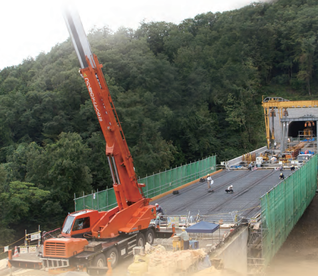
日高豊岡南工事中
