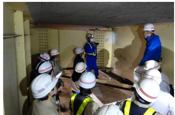
【疲労亀裂 磁粉探傷試験及び亀裂除去工説明状況】
