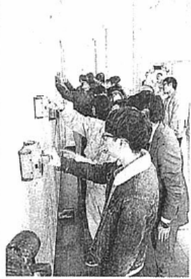
電磁波レーダーで壁内の配筋状態などを検査する学生たち
