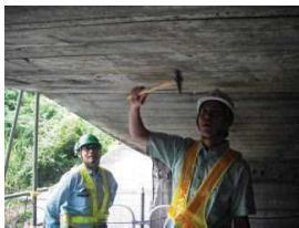
目視及びハンマーによる打音検査
