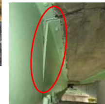
主桁の変形
