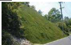
切土 (のり面保護)
