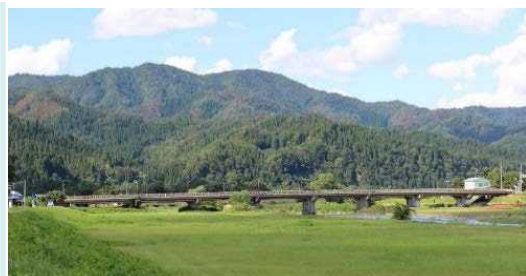
<万石橋の状況>
