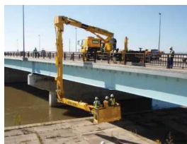
橋梁点検車による点検
