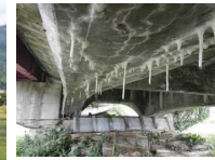
主桁のひびわれ
