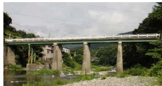
<御鉾橋の状況>
