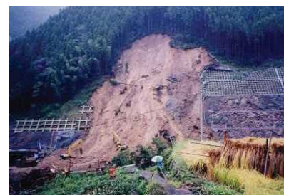
強風化・土砂化斜面での崩壊例
