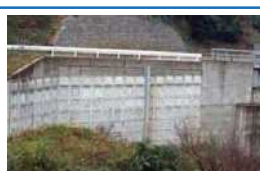
盛土 (補強土壁)
