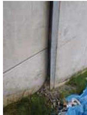
写真 土砂のこぼれ出し例
