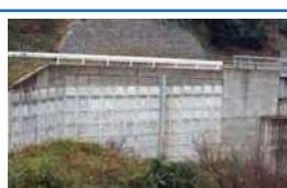
盛土 (補強土壁)
