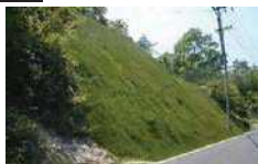
切土 (のり面保護)
