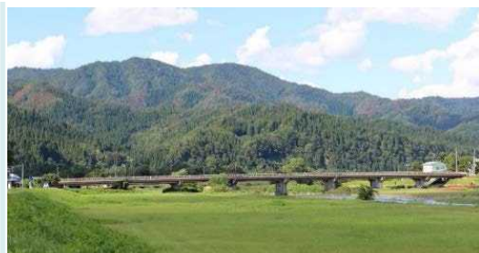
〈万石橋の状況〉
