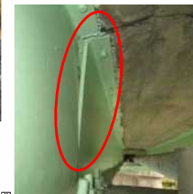
主桁の変形
