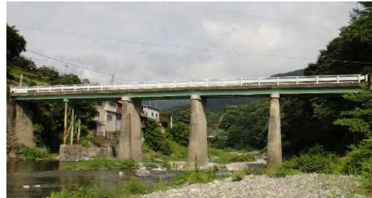
〈御鉾橋の状況〉
