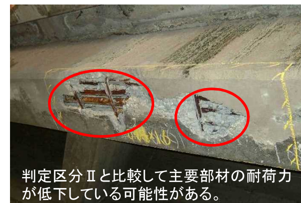
判定区分Ⅲ(主桁の断面欠損)
