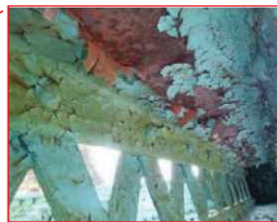
鋼材の腐食
