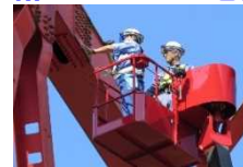
直轄診断(三島大橋)
