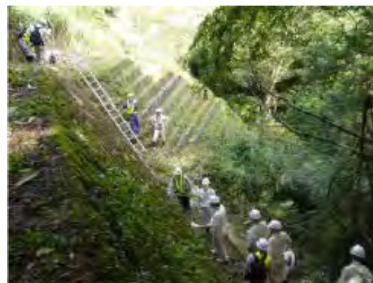
道路防災ドクターによる現地診断
