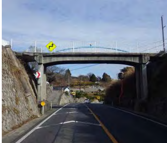
地方管理の跨道橋(未対策)
