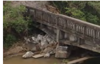
写真-2 平田・小柳線 田中橋
