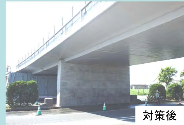
耐震補強の施工例
