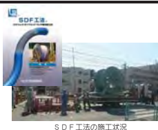
SDF工法の施工状況
