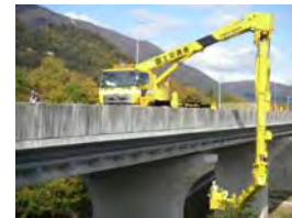
橋梁点検車による点検
