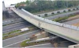
写真-1 県道小川嘉島線 府領第一橋
