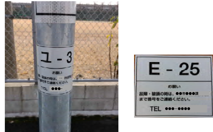
図-解 4-2 利用者から通報を受けやすく工夫している事例
