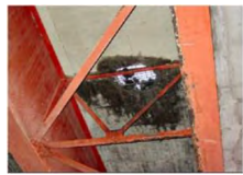
床版損傷例
