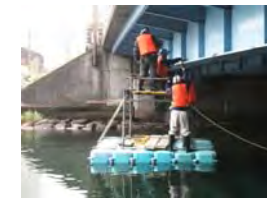
船(フロート)による点検
