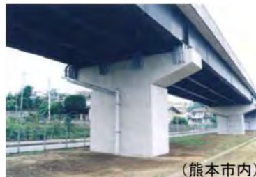
写真-3 国道3号 跨線部 (熊本市内)
