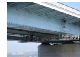
移動式吊足場による点検
