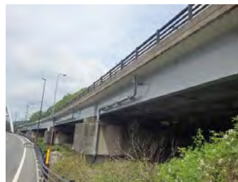
写真-4 阿蘇口大橋 (国道57号)
