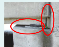
支承交換や桁端点検の空間なし
