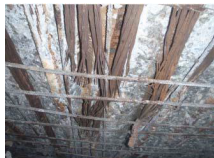
PC鋼材の腐食例
