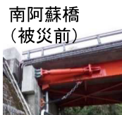
南阿蘇橋（被災前） 制震ダンパー取り付け部の損傷
