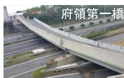
府領第一橋 ロッキング橋脚を有する橋の落橋
