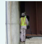
支承交換や桁端点検の空間なし
