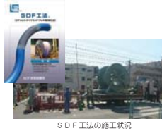
SDF工法の施工状況
