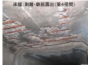
一般国道2号(兵庫県尼崎市)玉江橋 コンクリートの床版が剥離や鉄筋露出した例
