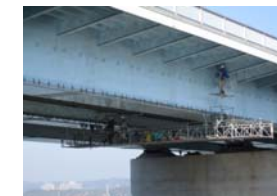
移動式吊場による点検
