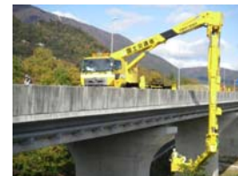
橋梁点検車による点検
