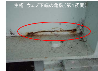
一般国道9号(兵庫県朝来市)和田山大橋 鋼製の主桁に亀裂が発生した例
