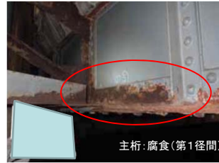
一般国道2号(兵庫県神戸市)新湊川大橋 鋼製の主桁が腐食した例
