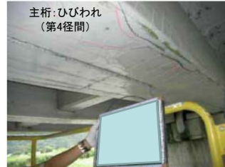
一般国道29号(兵庫県宍粟市)安積橋 主桁補修部にひびわれが発生した例
