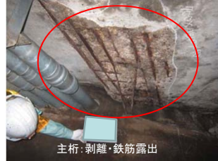
一般国道2号(兵庫県西宮市)今津3号橋 コンクリートの主桁が剥離や鉄筋露出した例
