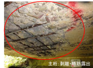
一般国道9号(兵庫県美方郡)大平橋側歩道橋(上) コンクリートの主桁が剥離や鉄筋露出した例
