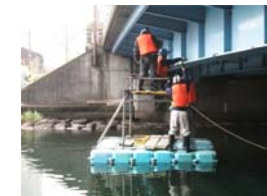
船(フロート)による点検
