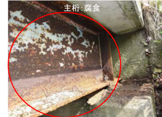
一般国道9号(兵庫県美方郡)谷入橋側歩道橋・下 鋼製の主桁が腐食した例
