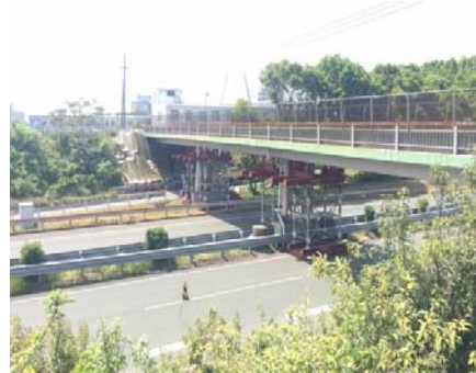
平成28年4月19日13時 応急復旧作業完了
