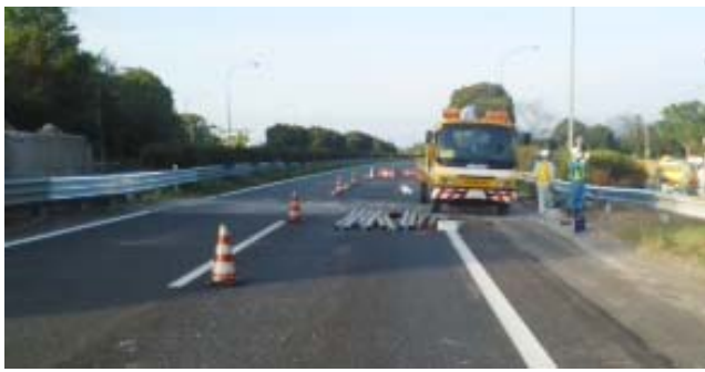
平成28年4月22日18時 撤去作業状況
