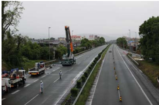
平成28年4月27日10時 撤去作業状況
