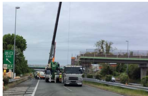
平成28年4月25日10時 撤去作業状況
