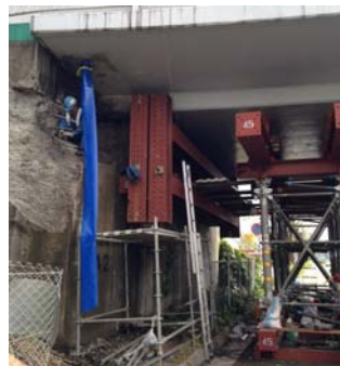
平成28年4月22日9時 応急復旧作業状況
