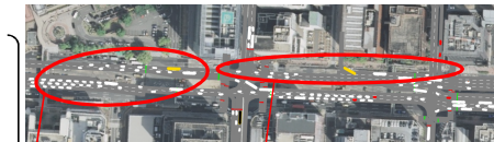
路上バス停の阻害がなくなり、交通流が円滑化 デッキ整備による歩車分離で、交通流が円滑化
