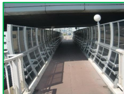
東本町西歩道橋
