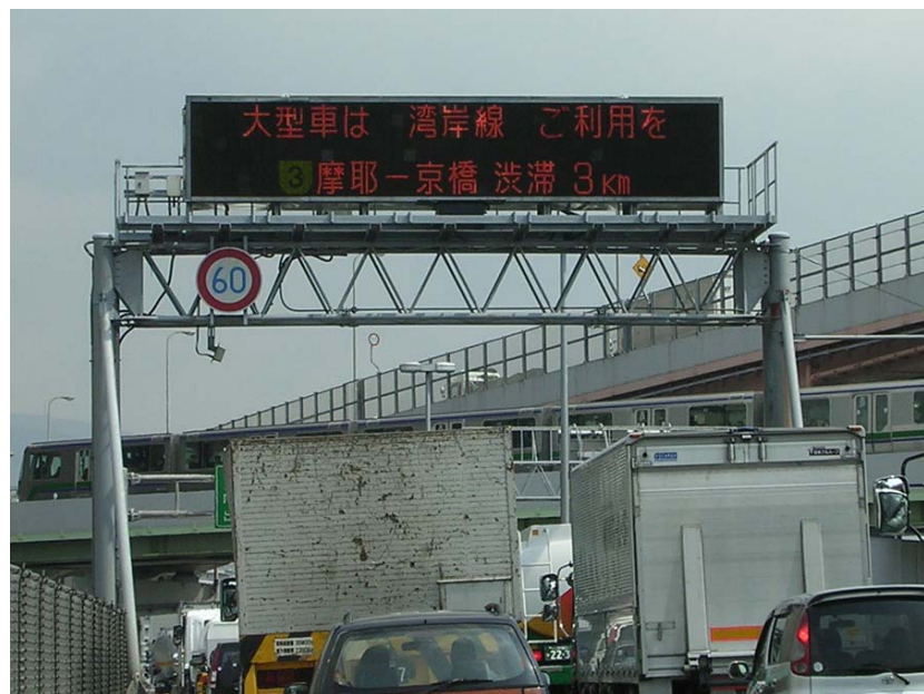
3号神戸線生田川・摩耶付近 道路情報板で湾岸線利用をPR
