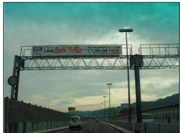
阪神高速3号神戸線 (魚崎ランプ付近、下り)
