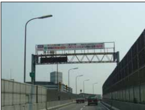
阪神高速16号大阪港線 (天保山ランプ付近、下り)
