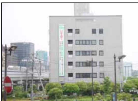
国土交通省 兵庫国道事務所 庁舎
