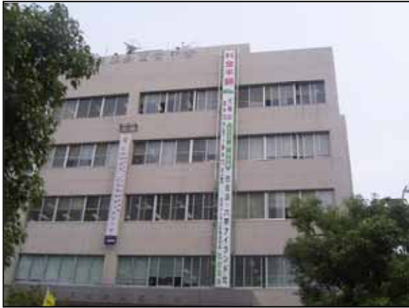
兵庫県 阪神南県民局 庁舎
