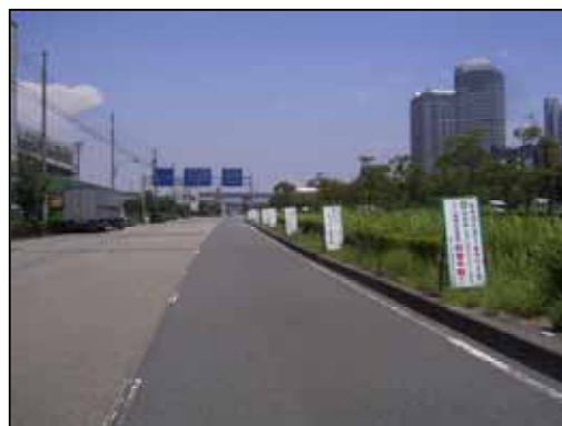
神戸市道 (六甲大橋六甲アイランド西側進入路)
