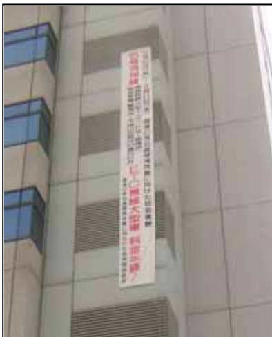
阪神高速道路(株) 神戸管理部 庁舎
