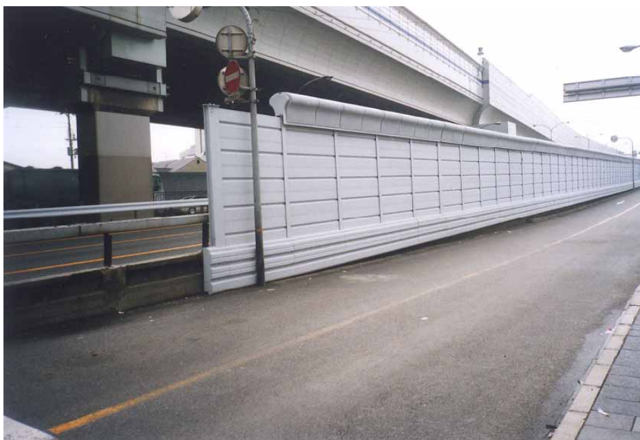
写真9. 光触媒によるフィールド実験 (尼崎市域：H14年度施工)
