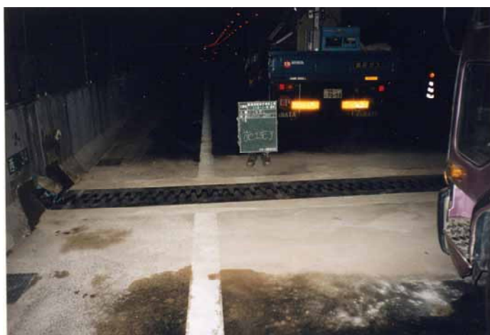
写真10. 鋼製伸縮継手の補修（尼崎市西本町付近）
