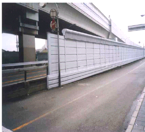
光触媒設置状況（尼崎市域）
