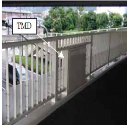
制震装置(TMD)設置状況（芦屋歩道橋）
