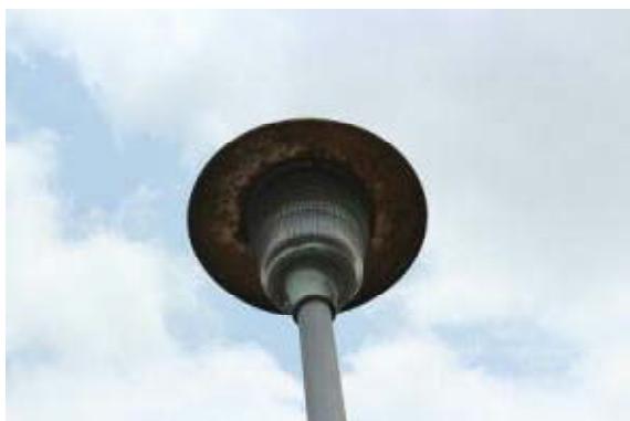
照明の美装化(鳴尾歩道橋・西宮市鳴尾町)
