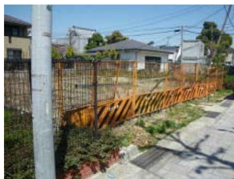
芦屋市打出町〔利用型〕施工前
