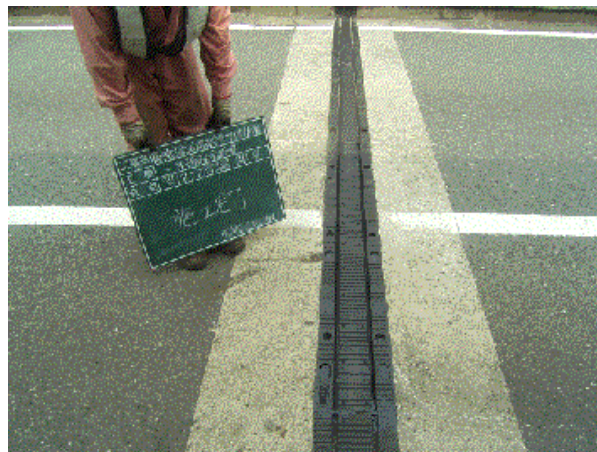
ゴム伸縮継ぎ手補修完了後
