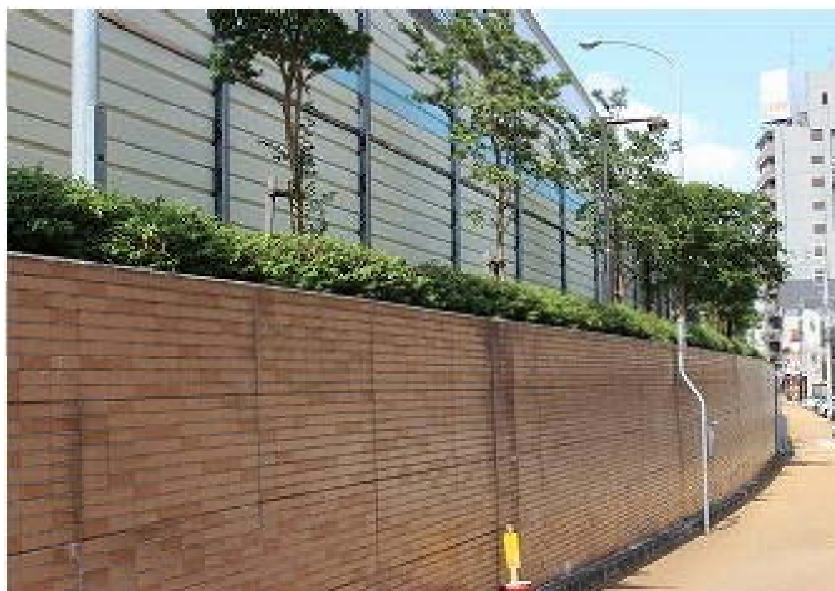
擁壁の美装化 着手後（神戸市灘区新在家南町）
