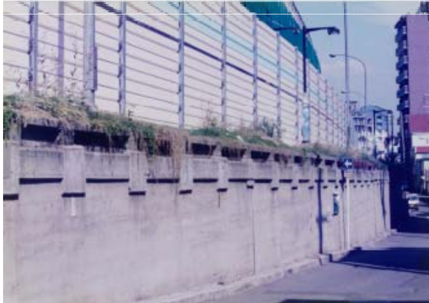
擁壁の美装化 着手前（神戸市灘区新在家南町）
