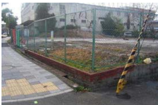
西宮市社前町〔基本型〕施工前
