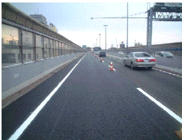
舗装補修完了後
