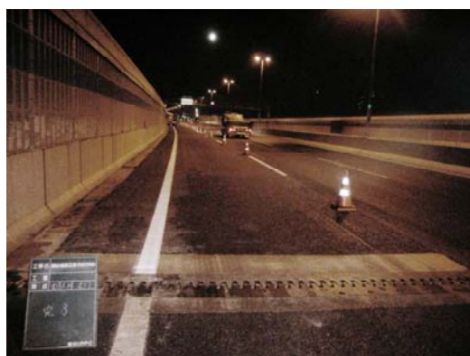
舗装補修完了後（尼崎集約料金所付近）
