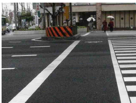
写真2 今津交差点(上り)完成後
