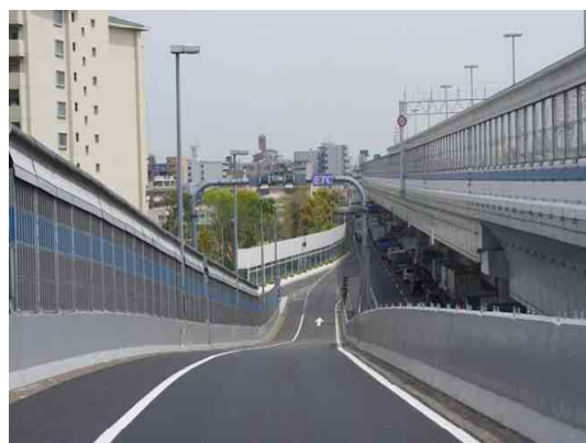
写真4 舗装補修完了後（深江出路）
