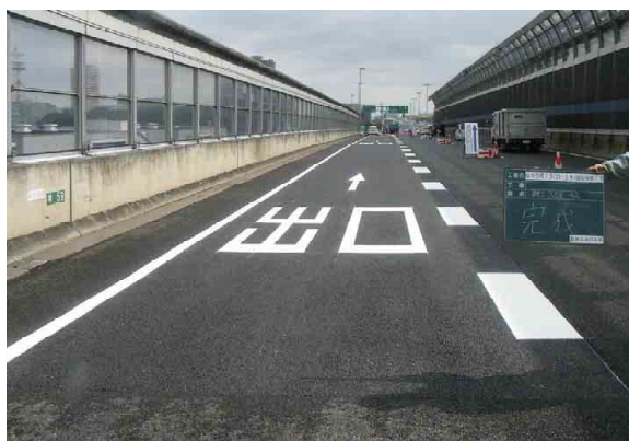
写真3 舗装補修完了後（西宮出路）
