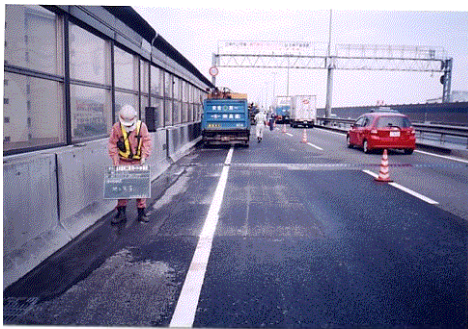
写真1 舗装補修完了後
