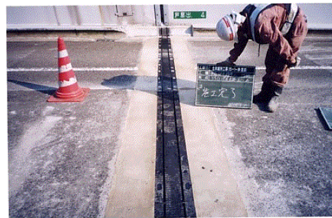
写真2 ゴム伸縮継ぎ手補修完了後
