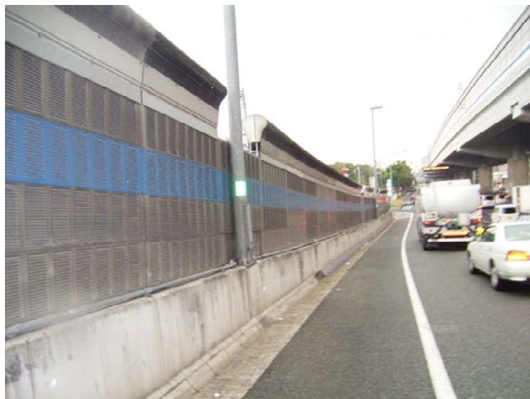
写真3 遮音壁の設置状況（西宮出口）
