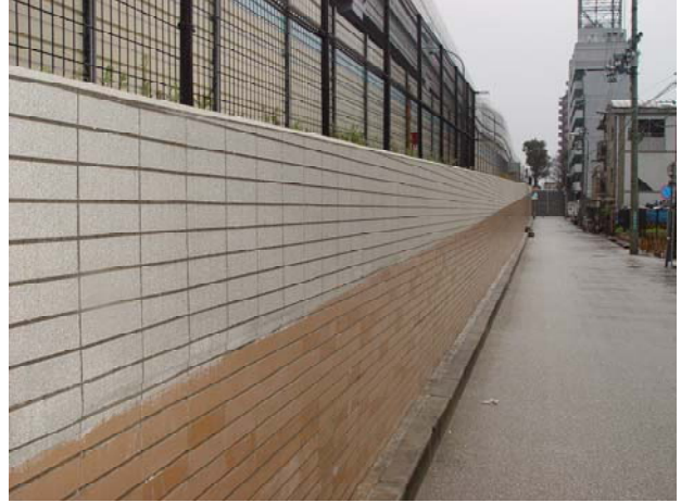
写真9 擁壁の美装化（西宮市川西町）
