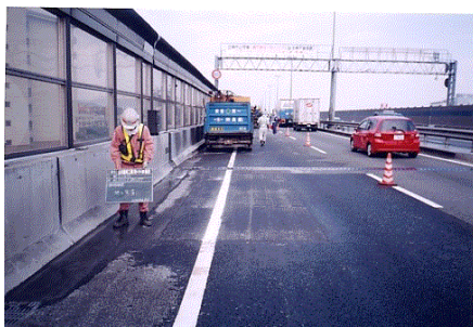
写真1 舗装補修完了後
