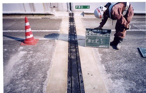
写真2 ゴム伸縮継ぎ手補修完了後
