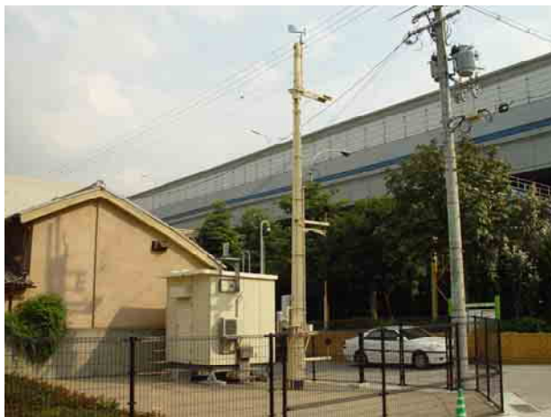
写真13 大気常時観測局の設置状況（尼崎市）
