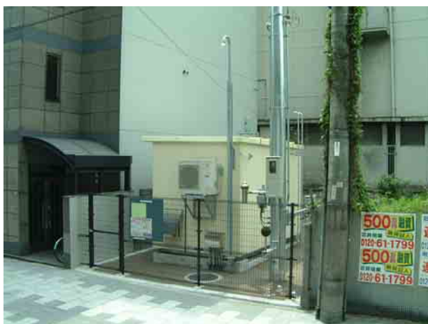
尼崎市 五合橋交差点局（平成13年度設置・交差点南西側）
