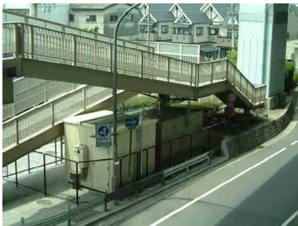
尼崎市 東本町交差点局（平成13年度設置・交差点南西側）
